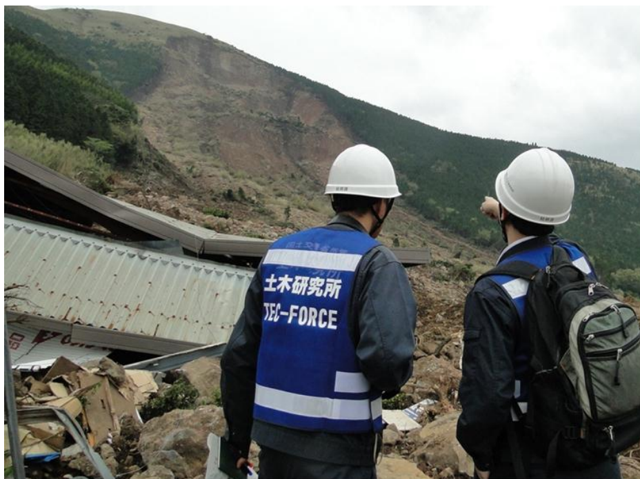
国道57号の土砂崩壊と阿蘇大橋落橋現場において、被災状況調査を行う土木研究所 職員①(4月17日)
