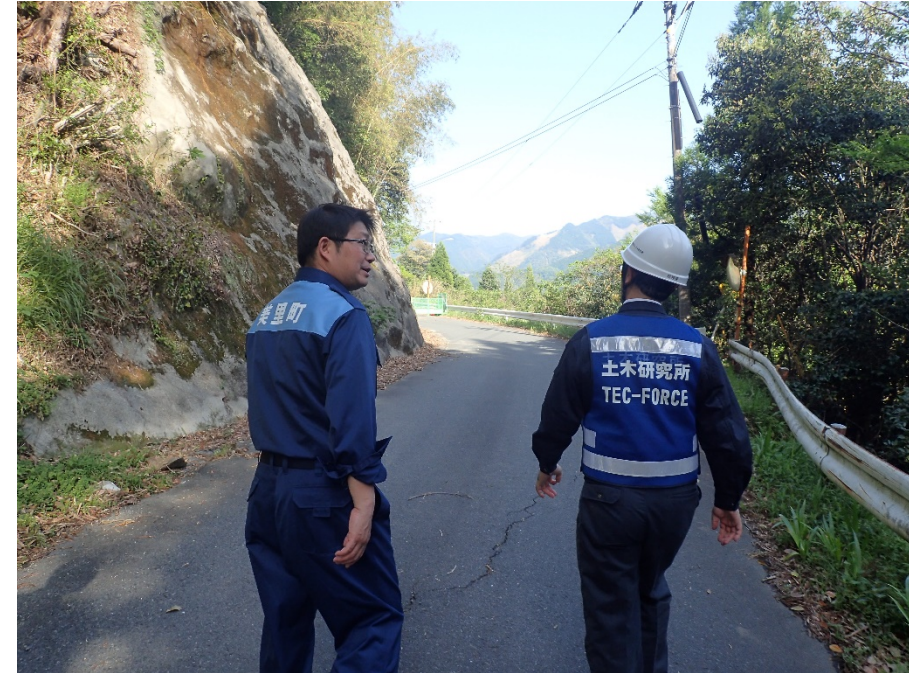
現地において美里町長に道路斜面の被災状況の説明を行う土研施工技術チーム上席研究員(4月22日)
