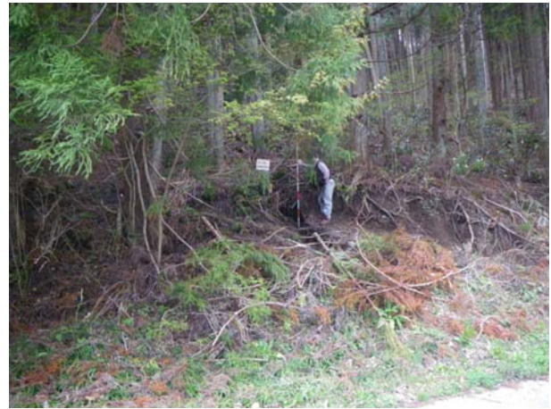
変状は北側斜面に続く。
