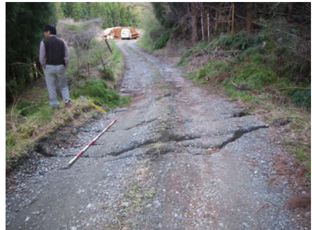
西を望む。左の写真にある道路は人物の左下にある。この道路では雁行亀裂でとう曲状の変形。50m先にも西落ちの段差有り。
