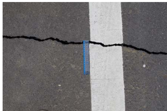
拡大写真。写真上が北側。 開口5mm、右横ずれ6mm
