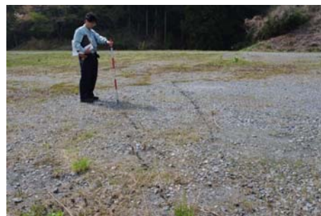
西を望む。左写真の北側の駐車場において発生した亀裂。
