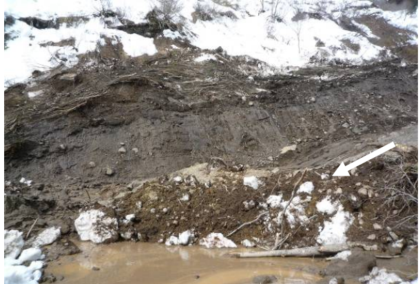
写真-4.3.3 「トマトの国」付近に残る土砂の流下痕
