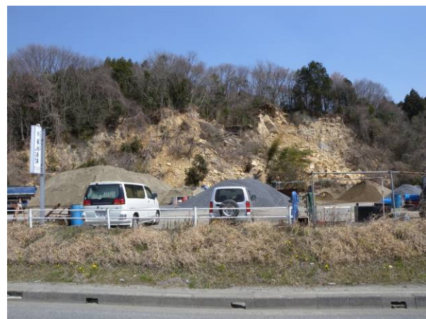
(b) 崩壊の全景
