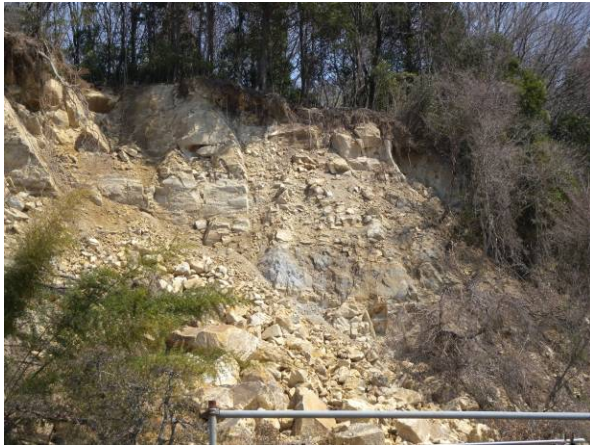
(c) 崩壊の状況
