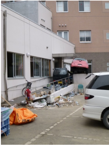
写真-4.5.13 老人福祉センター 南側壁面
