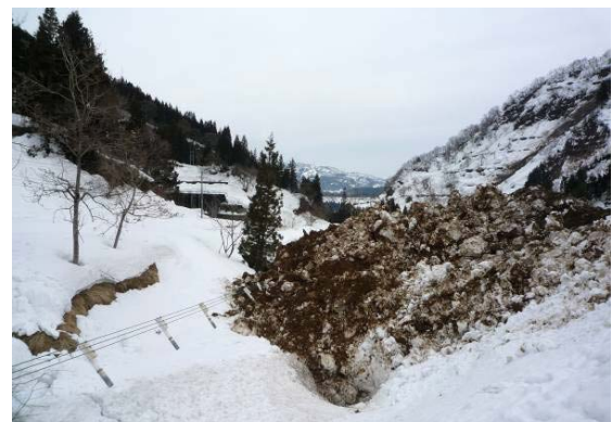
写真-4.3.10 移動した雪混じり土砂の末端部の状況
