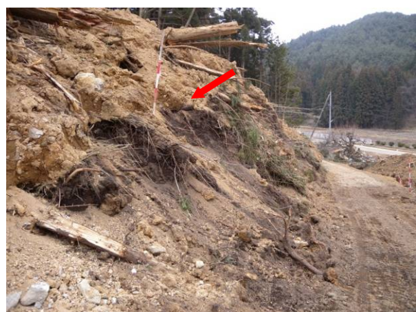
(f) 土砂が地すべりを横切る道を覆う状況 （土砂が植生と表土の黒土を覆っている）
