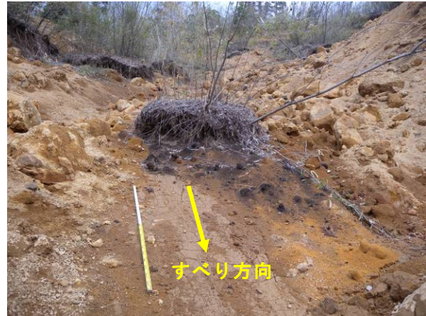
(d) すべり面の状況
