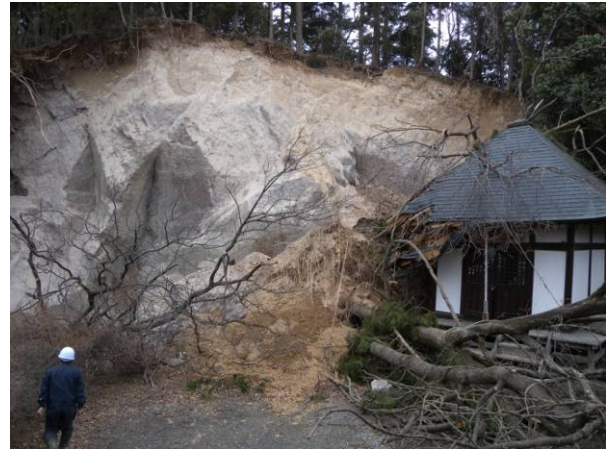
(b) 崩落した斜面の上部
