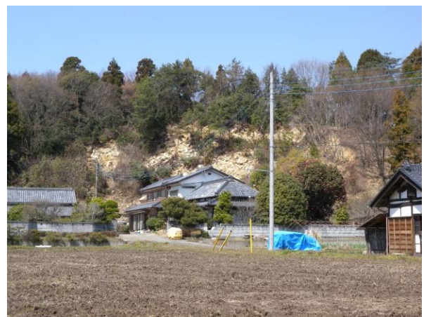
(b) 崩壊の全景
