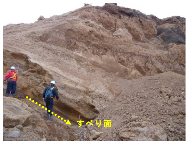
(f) 側方崖に露出したすべり面
