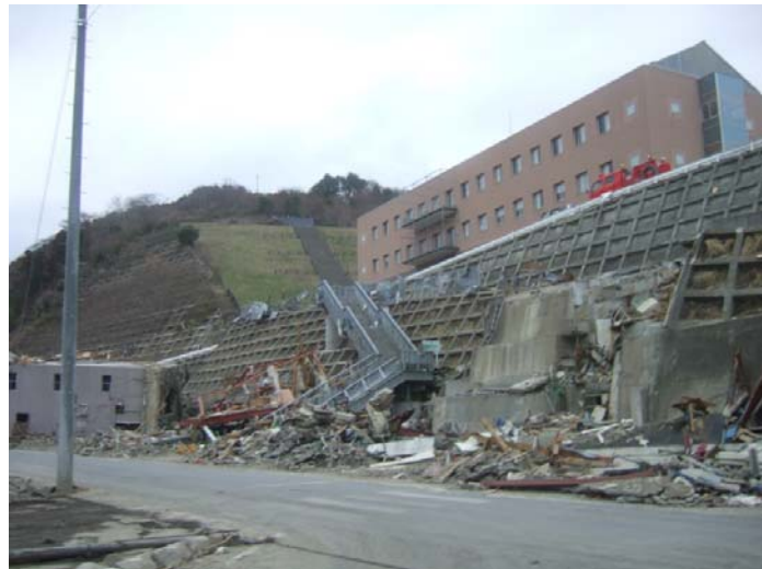
写真-4.5.15 津波避難用鋼製階段
