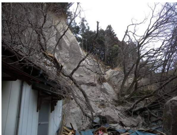
(c) 崩落した斜面の下部
