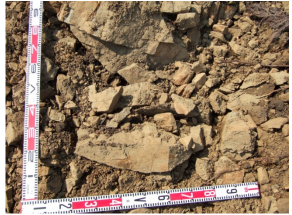
写真-4.6.6 テラスにおける崩壊土砂
