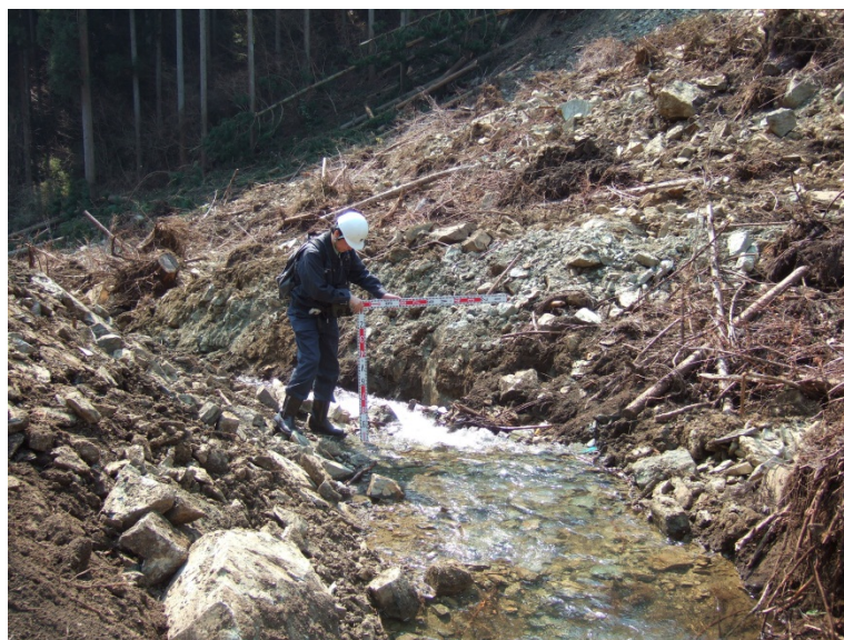
写真-4. 6. 13 開削された水路の断面（写真奥側下流）
