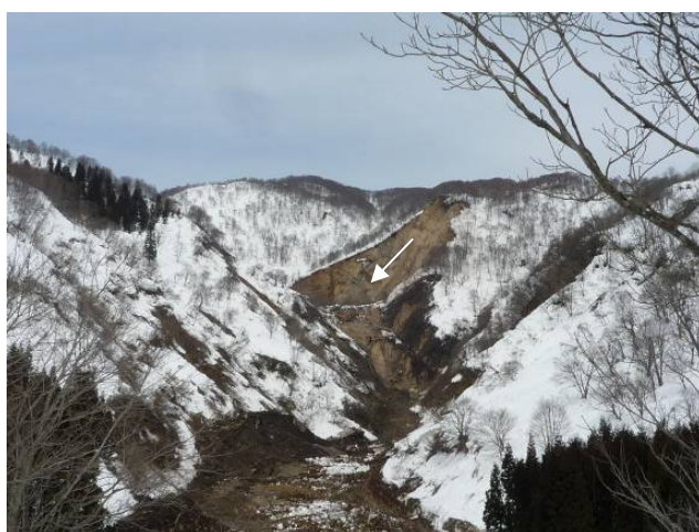
写真-4.3.1 「トマトの国」付近からの崩壊地②の全景
