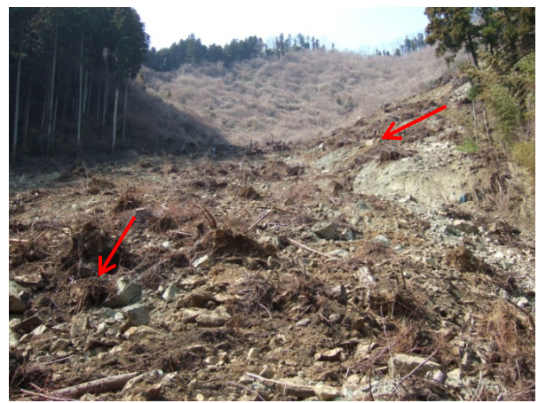
写真-4.6.3 左側の谷地形と摺り付き部
