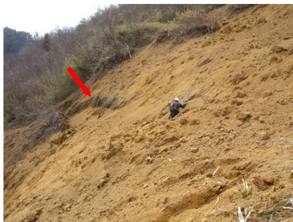
(d) 土砂が植生を覆う状況
