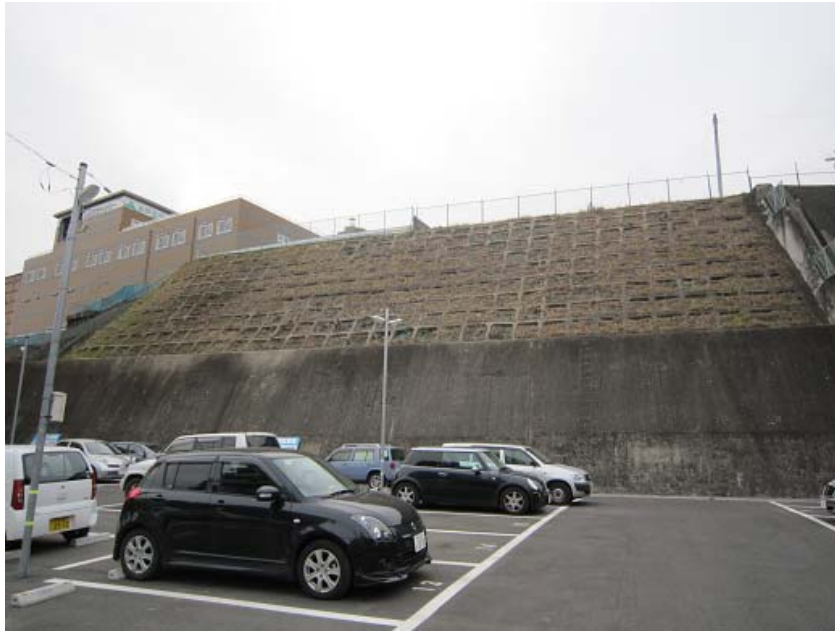
写真-4.4.7 擁壁工、のり砕工（擁壁に特に異常は見られず）
