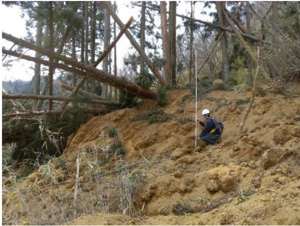
(e) 側部で堤防状に堆積した土砂
