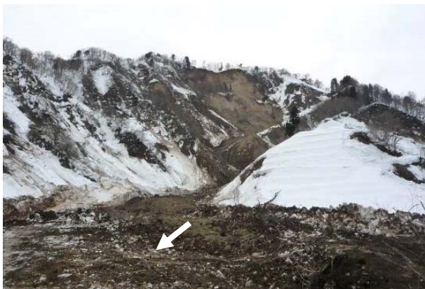
写真-4.3.7 堆積域中間部から見た崩壊地の全景
