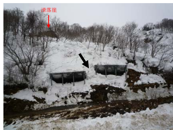
写真-4.3.18 地すべり斜面末端部の状況
