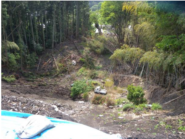
(g) 滑落崖から見た地すべり地（南側）
