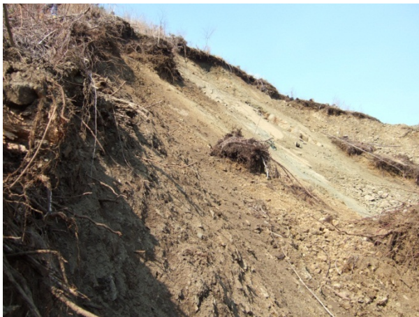
写真-4.6.2 崩壊源頭部（中央部に露岩が見られる）
