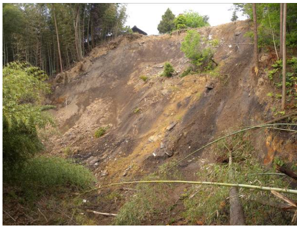
(c) 滑落崖の状況 (北側)
