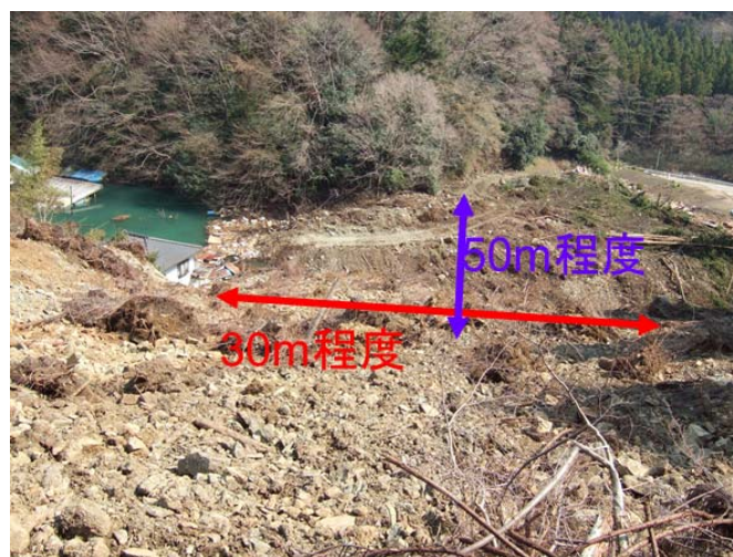
写真-4.6.11 崩壊地中腹から見た河道閉塞
