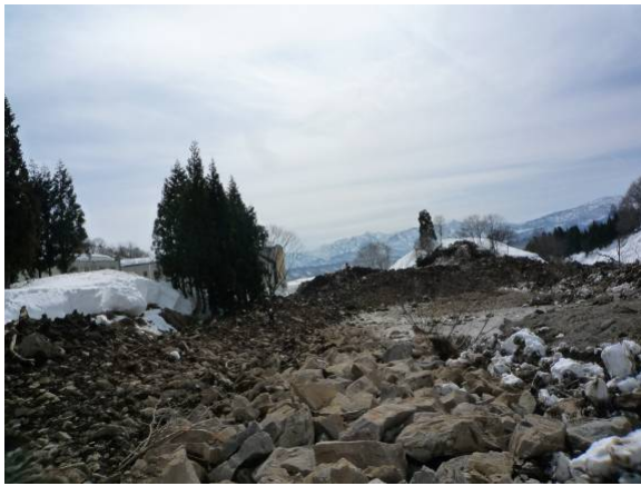
写真-4.3.4 「トマトの国」南西側の土砂堆積状況（下流を望む）
