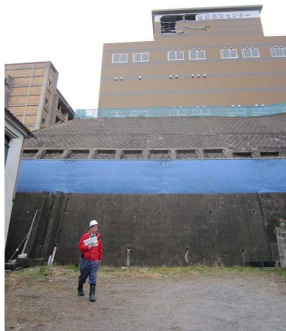
写真-4.4.6 擁壁工、のり砕工、積ブロック（擁壁に特に異常は見られず）
