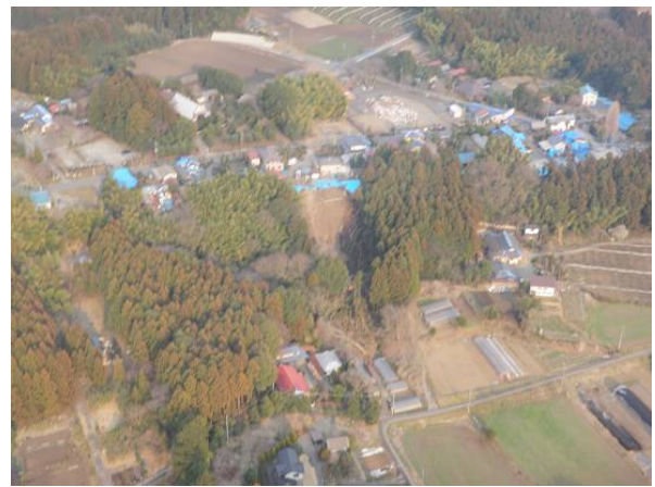
(f) ヘリから撮影した全景 (南側)
