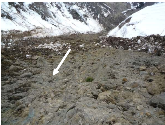
写真-4.3.9 堆積域中間部付近の堆積土砂の状況 (上流を望む)
