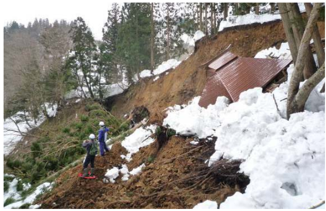
写真-4.3.15 地すべり斜面中間部の状況
