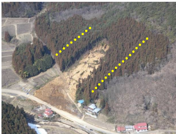
(c) 地すべりの両側に凹型（谷型）の地形 がみられた
