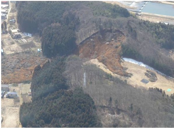
(c) 側方に乗り上げた土塊の一部
