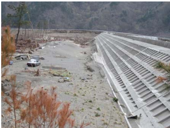
写真-5.4.38 南側堤防裏法尻被災
