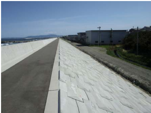
写真-5.4.1 連節ブロック裏法被覆工
