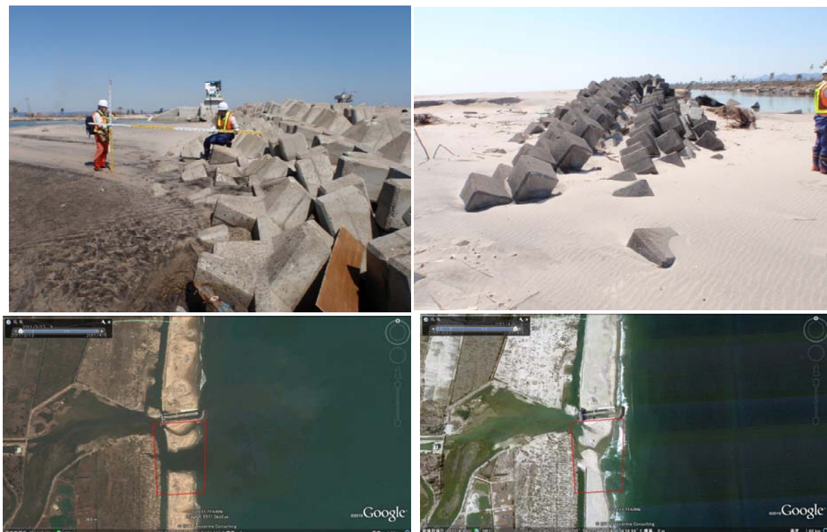
図-5.4.58 流路形成とその後のバームによる閉塞（牛橋水門脇）
