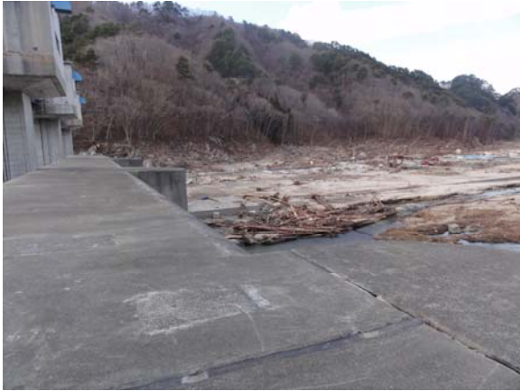
写真-5.4.24 陸側堤防は被災なし
