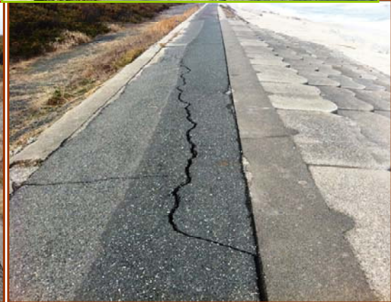
写真-5.4.130 天端のひび割れ
