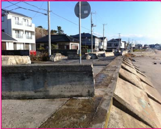
写真-5. 4. 125 波返し工倒壊 (金沢海岸)
