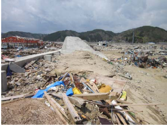
写真-5.4.45 一線堤区間の被災状況
