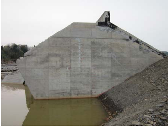
写真-5.4.54 隔壁工による破堤の拡大防止
