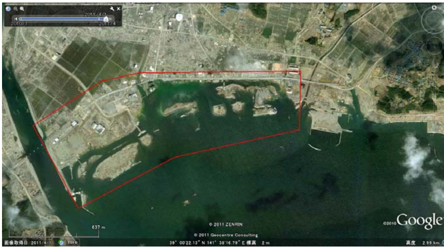
写真-5.4.74 陸前高田海岸津波後
