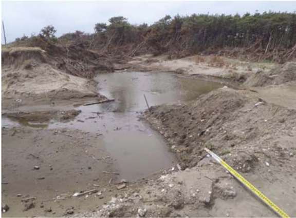
写真-5.4.150 洗掘被災（木戸川）
