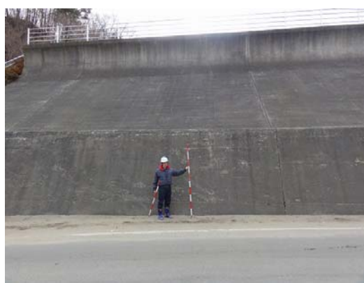
写真-5.4.30 津波を防いだ海岸堤防（太田名部海岸）
