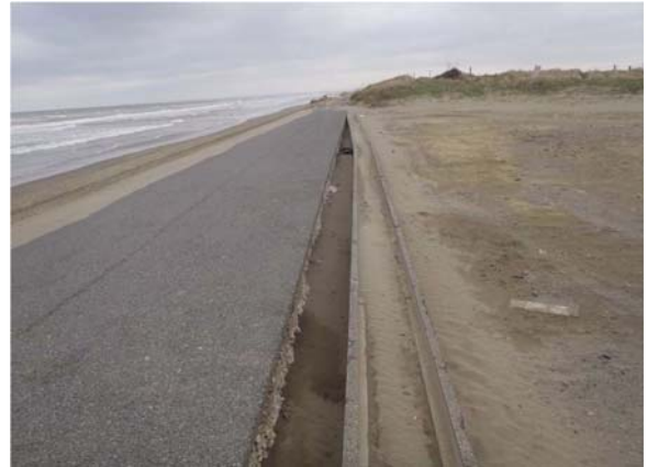
写真-5.4.153 裏法排水溝移動（片貝海岸）
