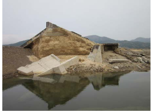
写真-5.4.55 堤防断面（嵩上げ拡大）
