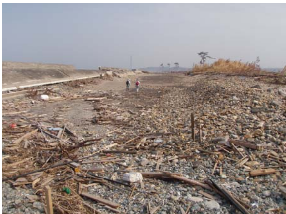
写真-5.4.117 堤防背後の洗掘状況。破堤箇所に向かって流れた形跡
