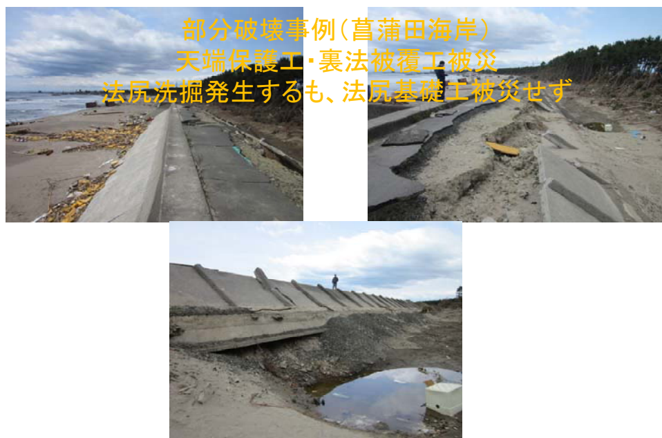
図-5.4.23 破堤箇所(菖蒲田海岸)
