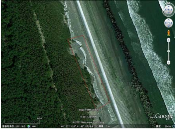
写真-5.4.9 裏法被覆工等の流失状況
