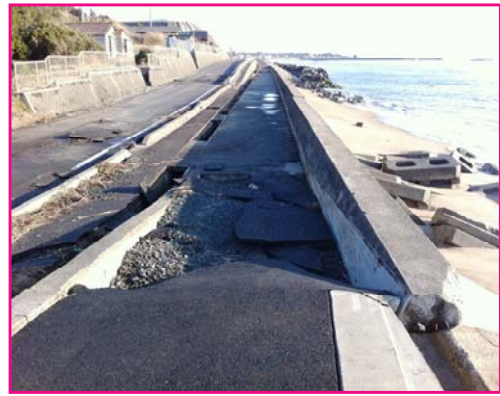
写真-5. 4. 125 波返し工倒壊 (金沢海岸)
