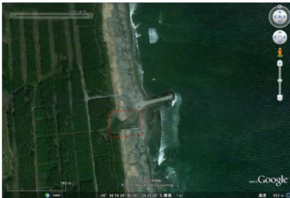
写真-5.4.12 引き波によると思われる排水路の流路拡大跡
