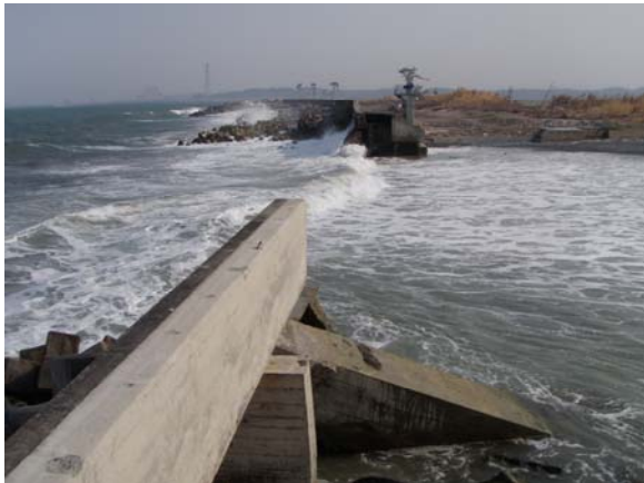
写真-5.4.115 破堤・全壊、海岸線後退
