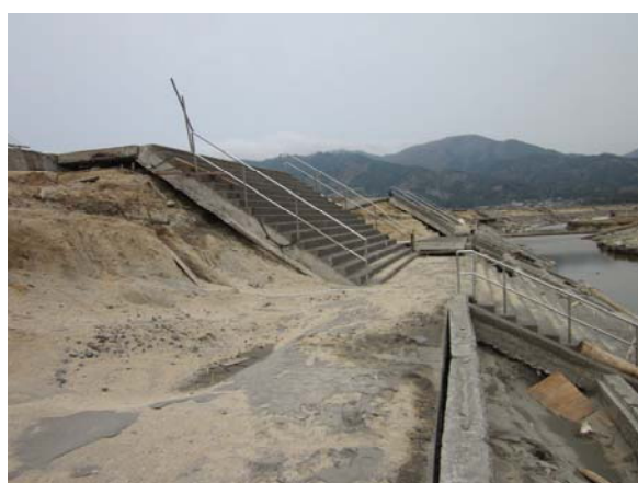
写真-5.4.52 裏法被覆工が階段護岸の部分が残存
