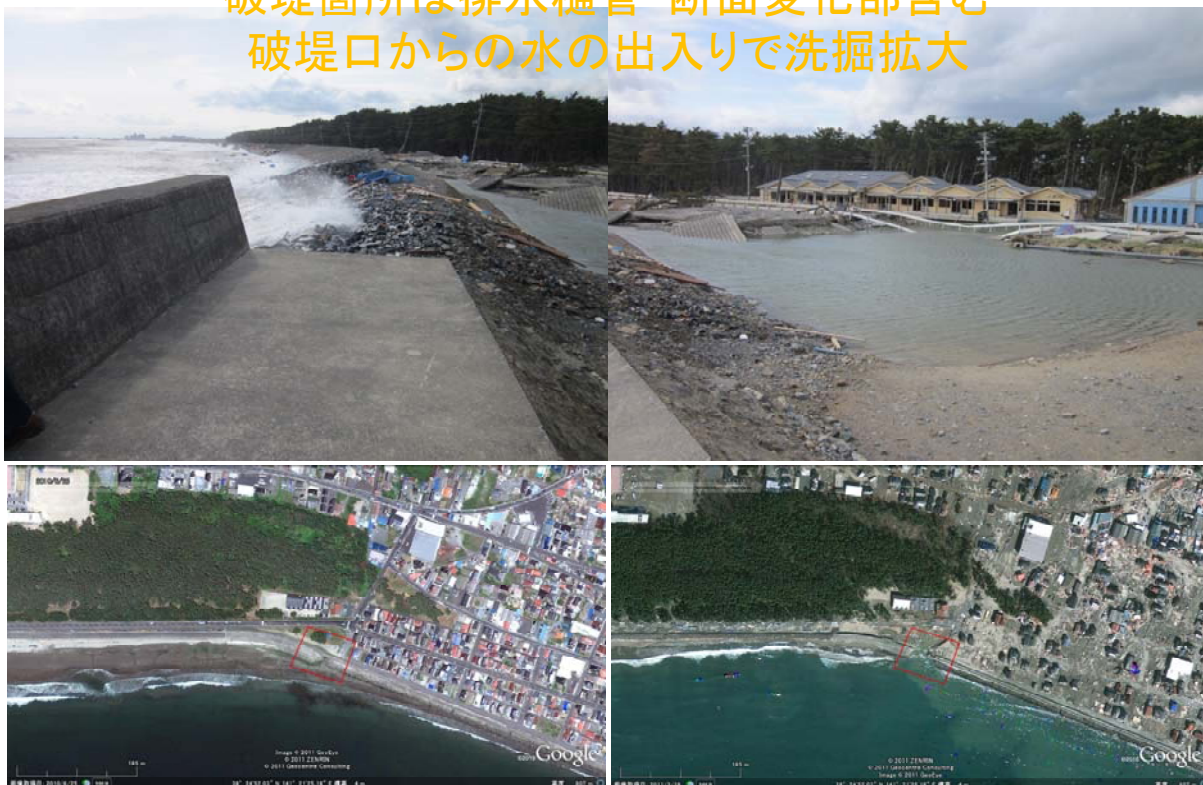
図-5.4.20 長浜海岸破堤箇所
