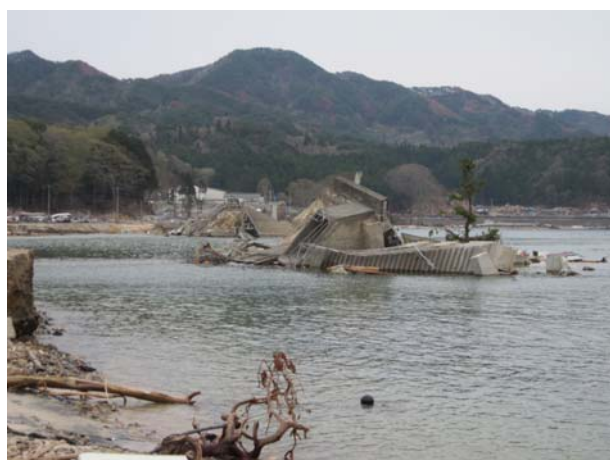
写真-5.4.59 破堤・海岸線後退
