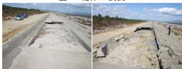
天端保護工・裏法被覆工・堤体は流失した ものの表法被覆工は残存
