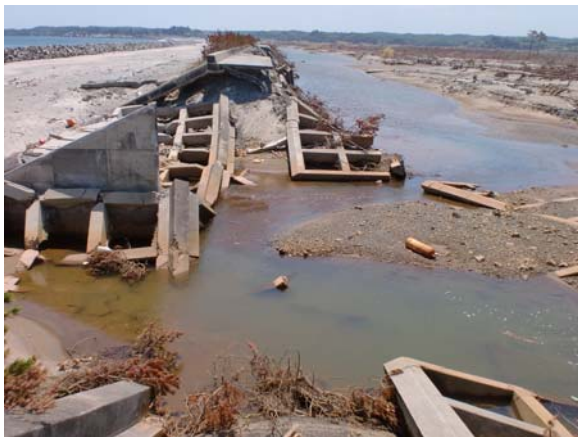
写真-5.4.92 歯抜け状の破堤
