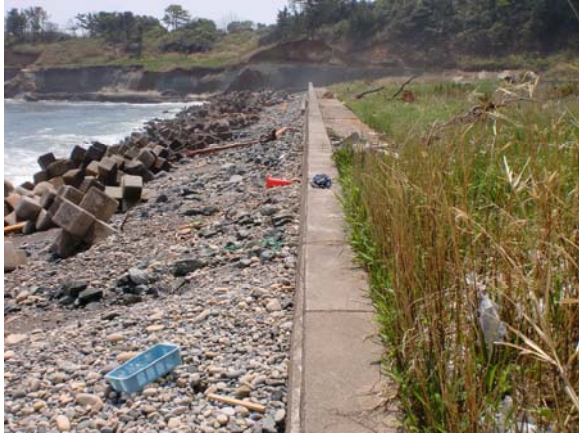
写真-5.4.101 越流あったが護岸には被災なし
