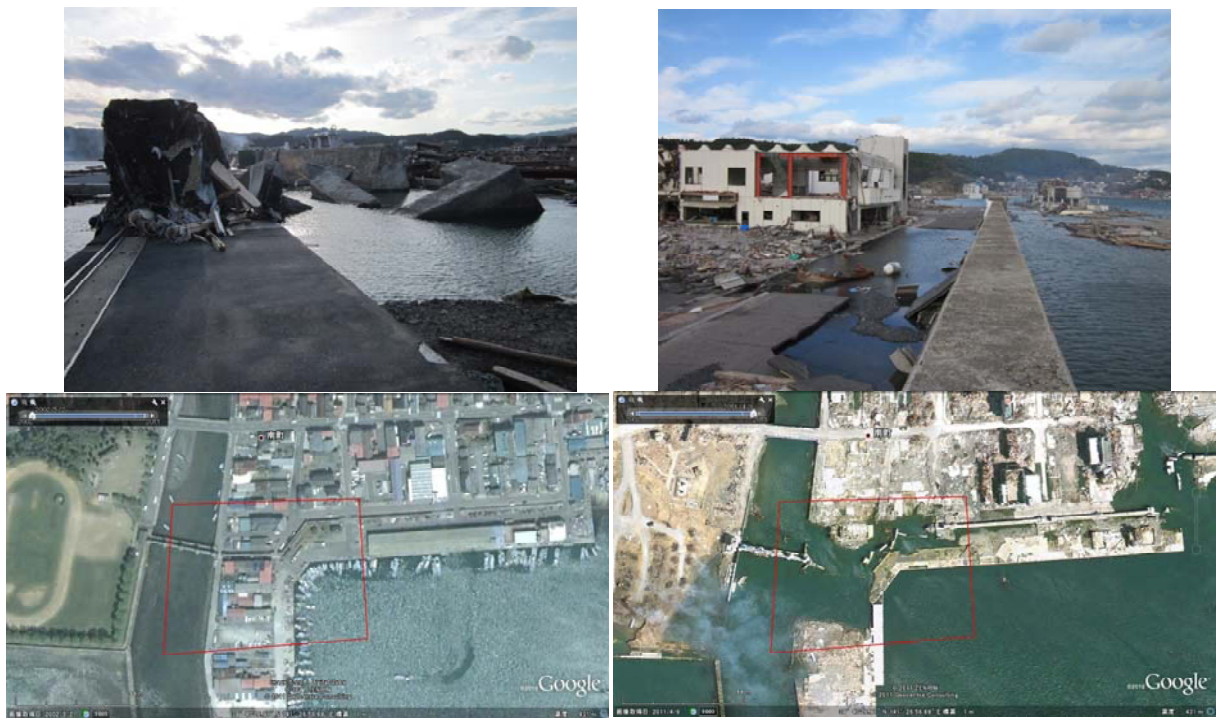
図-5.4.19 胸壁の破堤・洗掘
