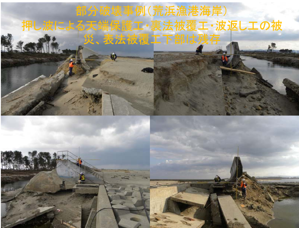
図-5.4.54 表法被覆工下部残存（荒浜漁港海岸）
