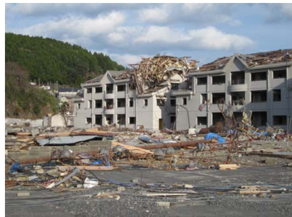
写真-5.4.78 3階建物の屋根に残る痕跡
