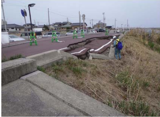
写真-5.4.133 天端表法被災（飯岡海岸）
