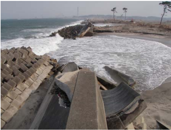
写真-5.4.121 歯抜け状の破堤
