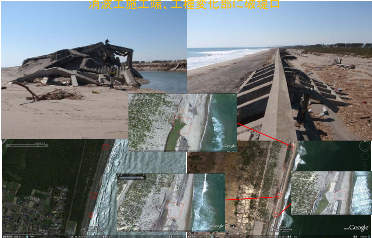
図-5.4.48 歯抜け状の破堤、消波工端部、工種変化部 (二ノ倉海岸)
