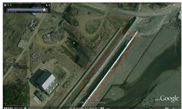
写真-5.4.23 一線堤の被災(裏法被災)
