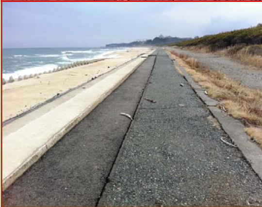
写真-5.4.130 天端のひび割れ
