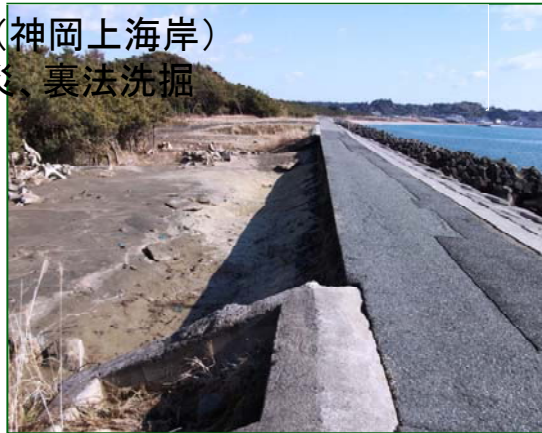
写真-5. 4. 125 波返し工倒壊 (金沢海岸)
