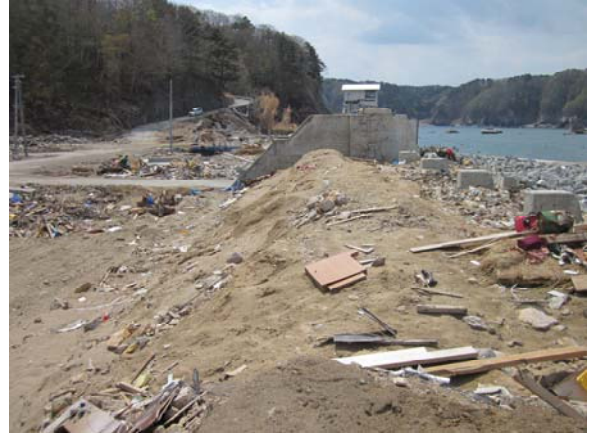
写真-5.4.46 一線堤区間の被災状況
