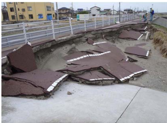
写真-5.4.134 天端表法被災（飯岡海岸）
