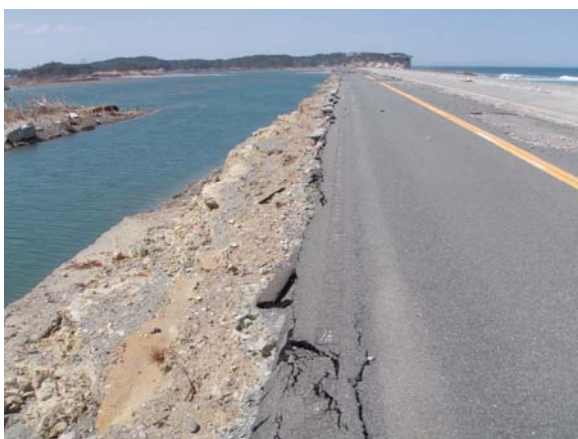
写真-5.4.89 天端と同じ高さの盛土道路が削り代となって堤防を守っている。
