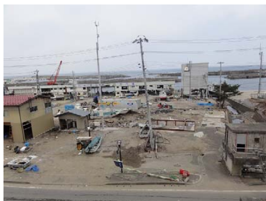
写真-5.4.32 津波被害を受けた海岸堤防海側（太田名部海岸）
