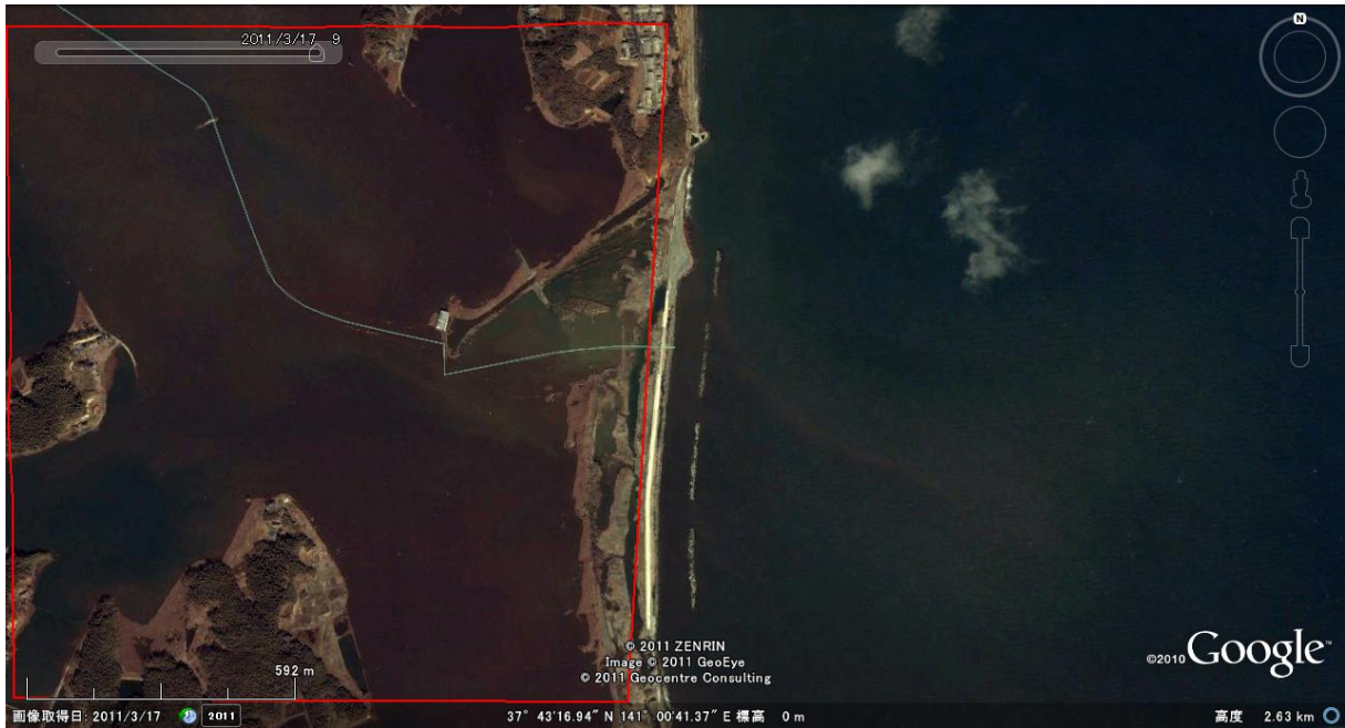
写真-5. 4. 110 北海老地区海岸津波後
