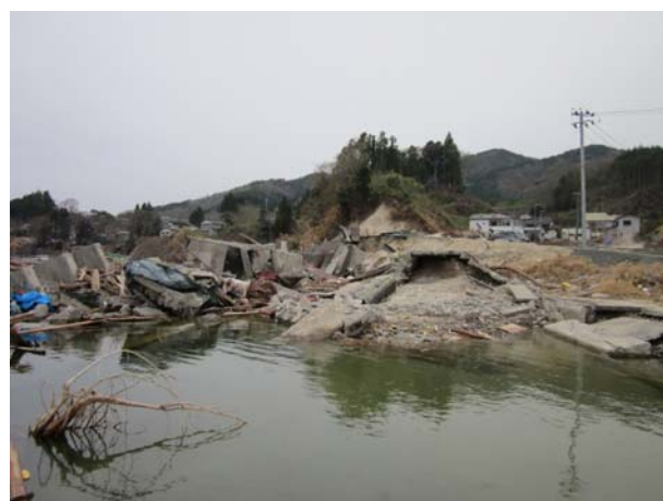
写真-5.4.60 破堤・海岸線後退
