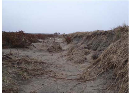
写真-5.4.136 盛土背後洗掘（飯岡海岸）
