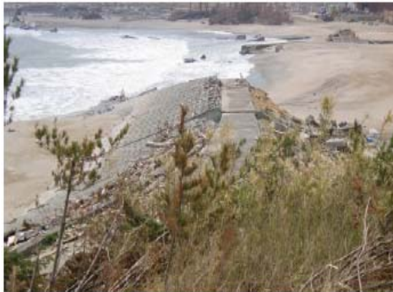
写真-5.4.83 破堤・全壊、海岸線後退（埴浜地先海岸）
