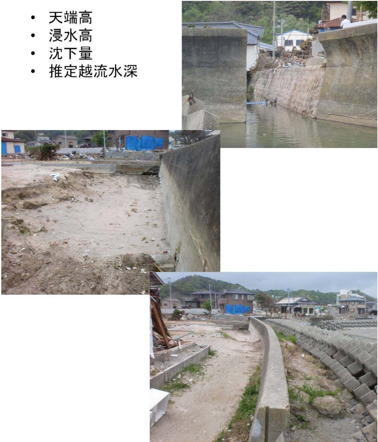
図-5.4.68 流入河川部分での洗掘(豊間地区海岸)
