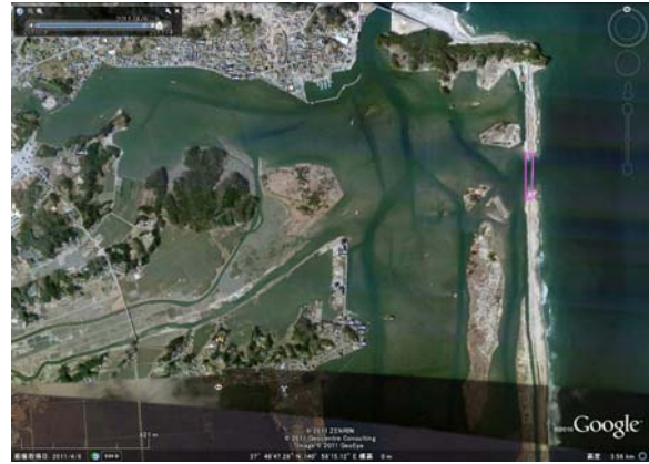
写真-5.4.86 大浜地先海岸北部（津波後）
