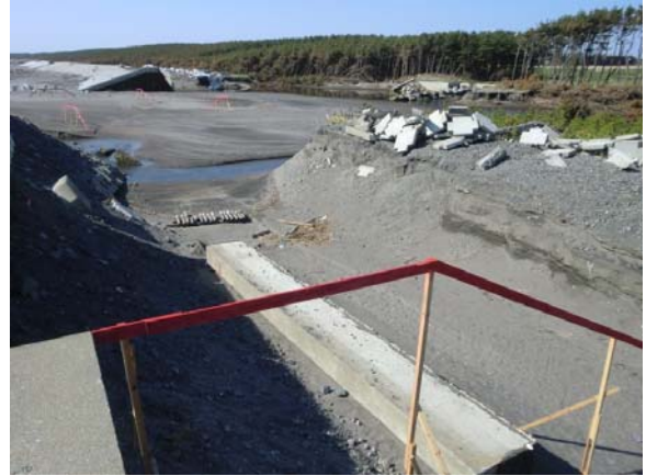
写真-5.4.15 引き波時に施工端に向かったと思われる堤防背後の流路跡
