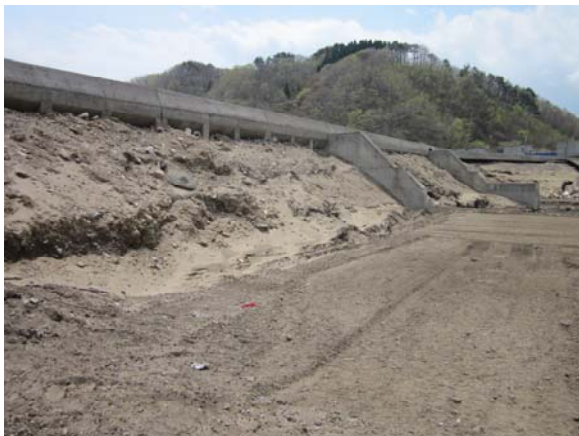
写真-5.4.47 二線堤海側堤防の裏法被災 (法尻洗掘は埋め戻されている)
