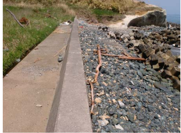
写真-5.4.102 越流あったが護岸には被災なし
