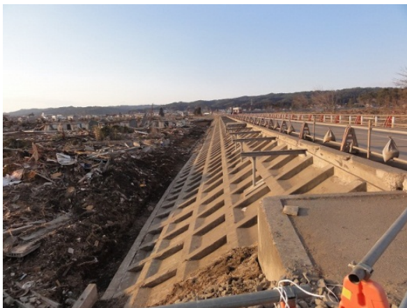
写真-5.4.22 陸側堤防は被災なし
