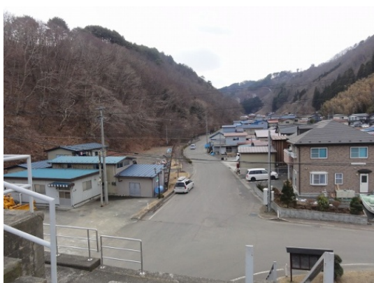
写真-5.4.31 被害がなかった海岸堤防陸側（太田名部海岸）
