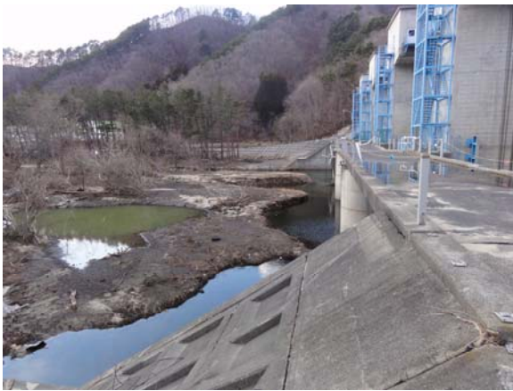
写真-5.4.26 水門は大きな被災なし
