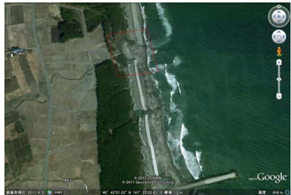
写真-5.4.13 施工端、排水路周辺の引き波によると思われる流路拡大跡
