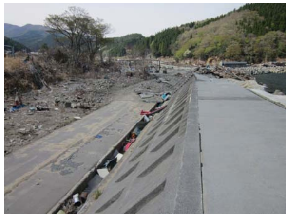
写真-5.4.72 裏法尻は道路で洗掘防止
