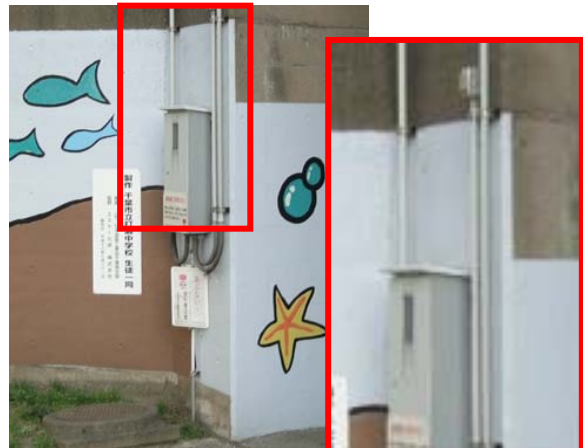
(m) 上流側の橋台と擁壁の接合部
