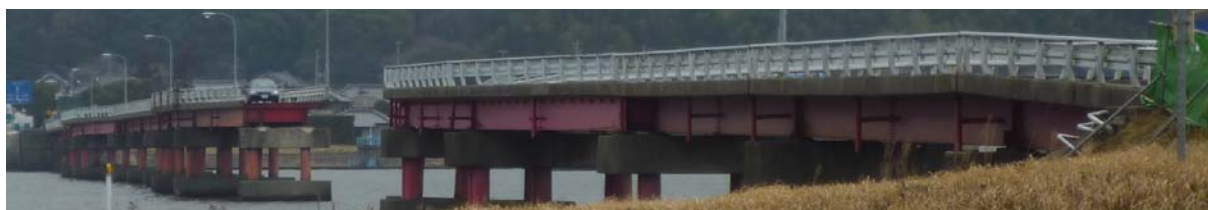
写真-9.59 鹿行大橋全景
