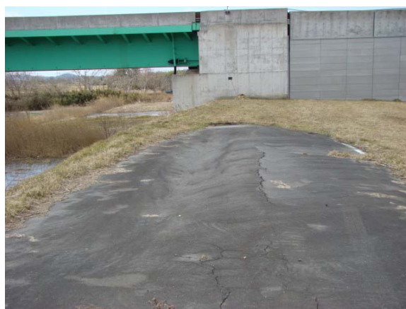
写真-9.56 A 2 橋台付近の液状化痕跡
