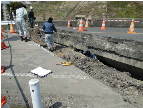
写真-9.87 橋台背面の補修の状況
