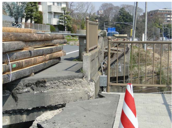
写真-9.88 橋台背面の沈下と橋軸直角方向への横ずれ
