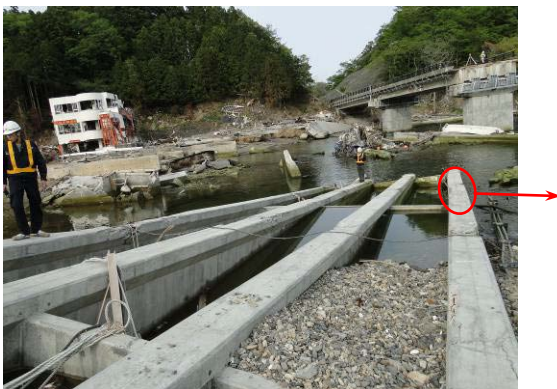
写真-9.127 流出している桁の状況
