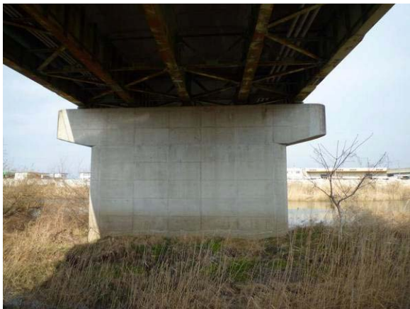
写真-9.164 P2橋脚(A1側から撮影)
