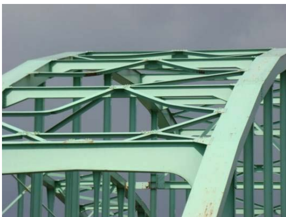
写真-9.47 上横溝座屈（遠景）
