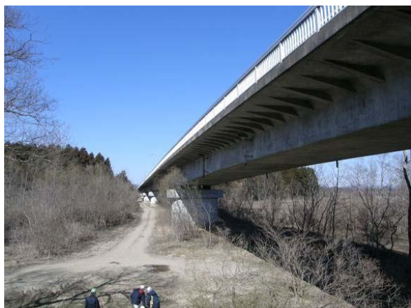
写真-9.1 橋梁全景
