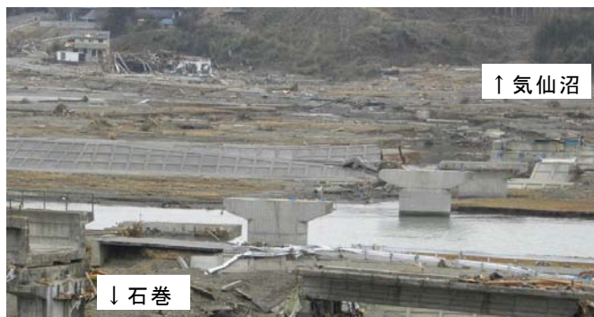
写真-9.109 地震後（左）と地震前（右）の小泉大橋
