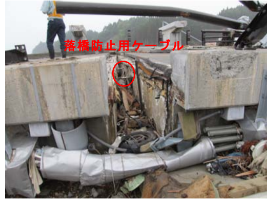
写真-9.130 桁間の落橋防止用ケーブル
