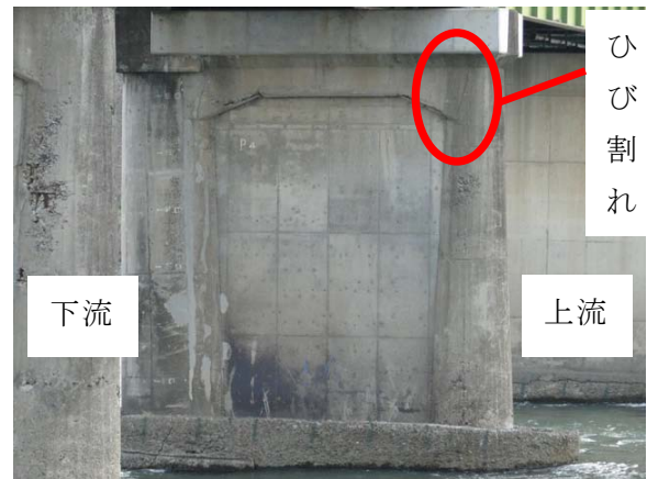
写真-9.91 P 4 橋脚の状況
