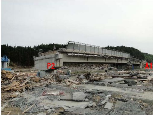
写真-9.123 A 1 ～ P 2 間の状況
