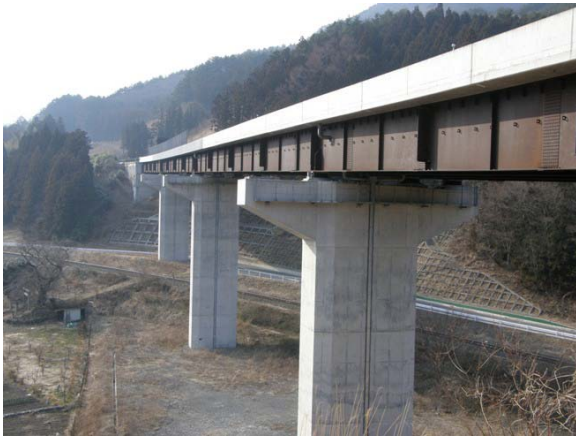
写真-9.82 甲子跨線橋
