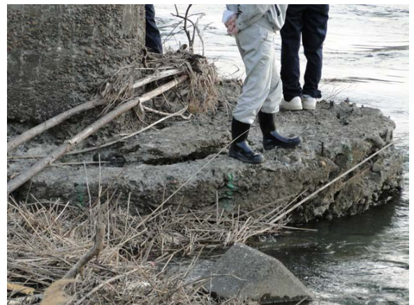
写真-9.97 P 2 橋脚ケーソン基礎の状況 (上流側)
