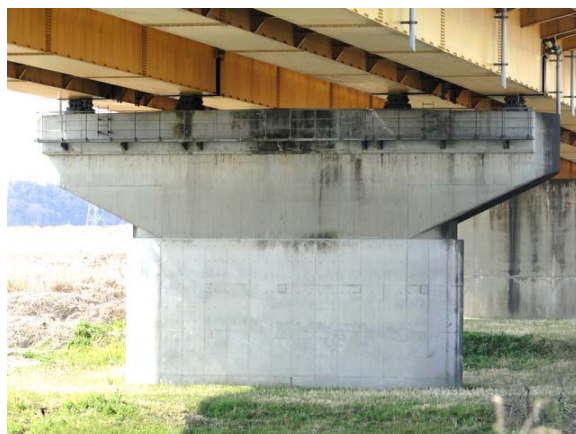
写真-9.24 那珂川橋の耐震補強された RC 橋脚の状況
