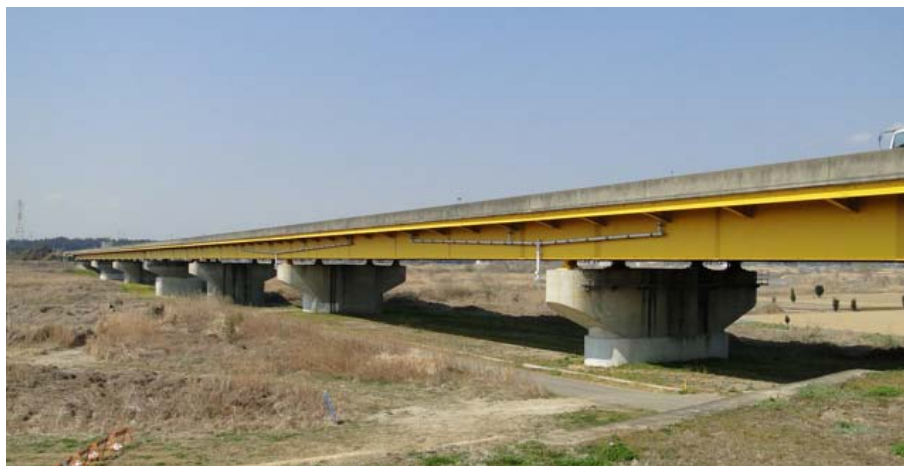
写真-9.23 那珂川橋
