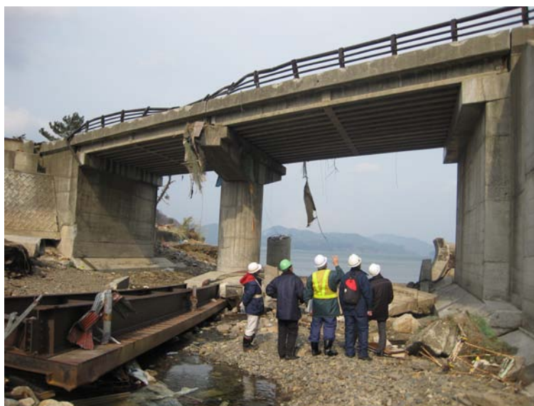
写真-9.1 調査状況
