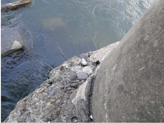
写真-9.98 P 2 橋脚のケーソン基礎の状況 (下流側)
