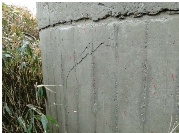
写真-9.108 藤橋の P 5 橋脚の損傷
