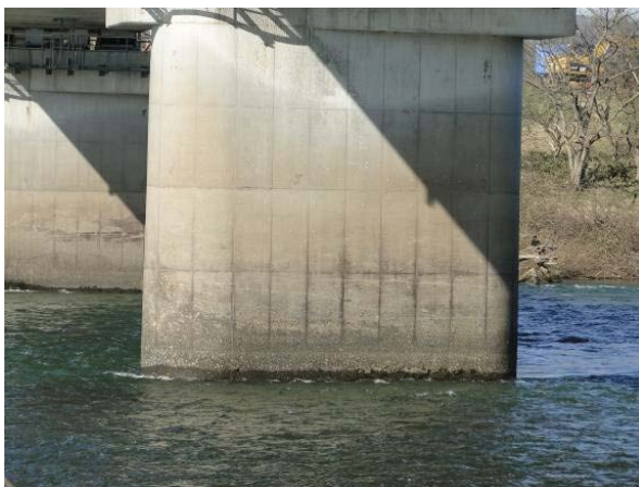
写真9.9 低水域の橋脚の状況
