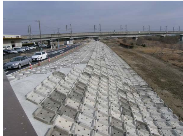
写真-9.153 左岸（江合橋 A 2 下流側）の堤体状況：液状化により大きく損壊。既に復旧工事が実施されていた。
