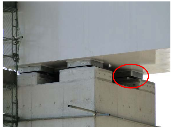
写真-9.69 写真-9.68のトラックの位置付近から見たP 5 6 橋脚のRC柱頭部
