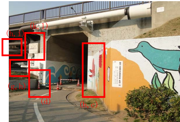
(a) A1橋台全景(河口側より撮影)
