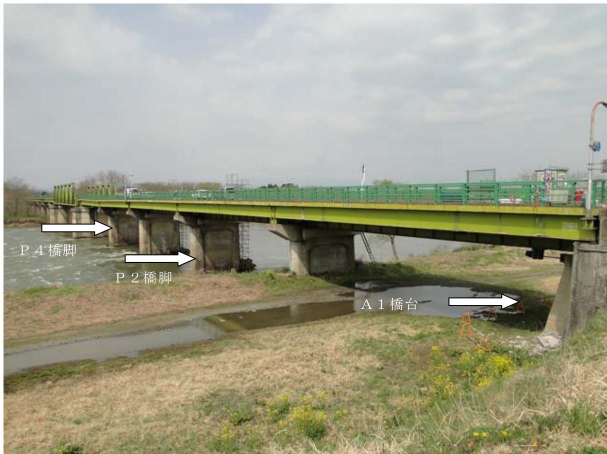
写真-9.89 小谷木橋（A 1 橋台側から A 2 橋台を望む）
