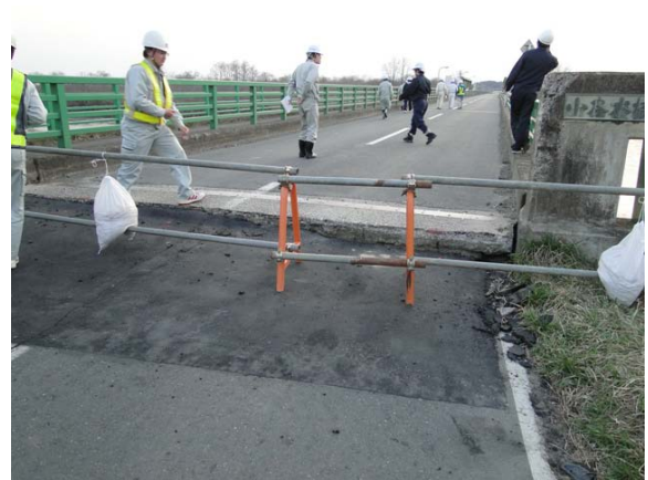
写真-9.105 A 1 橋台背面の段差の補修
