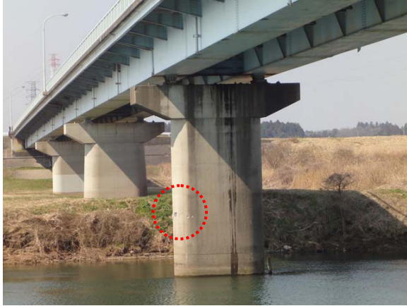
(a) P 2 橋脚側より撮影
