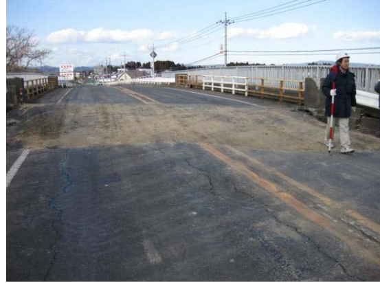
写真-9.31 広範にわたる顕著な盛土部の沈下、路面ひび割れなど
