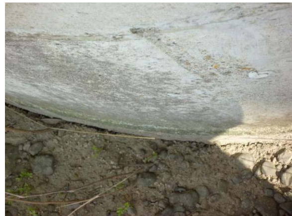
写真-9.165 P2橋脚基部
