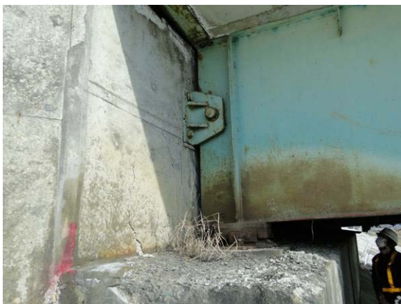
写真-9.168 A 2 橋台の状況
