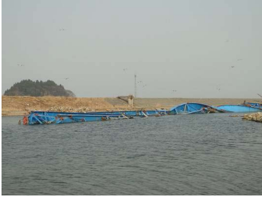
写真-9.112 流出した上部構造の状況
