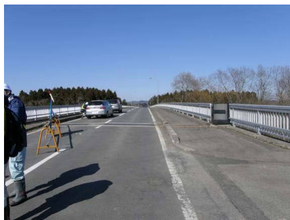
写真-9.2 A2橋台付近の状況
