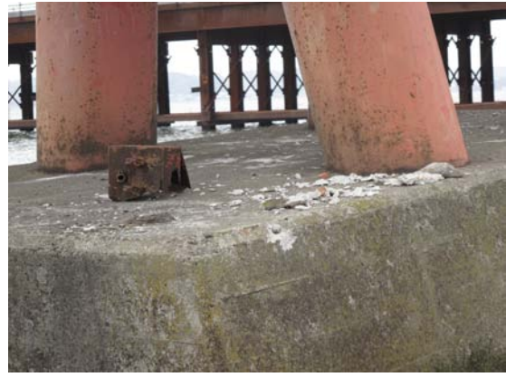
写真-9.63 下横梁の下面
