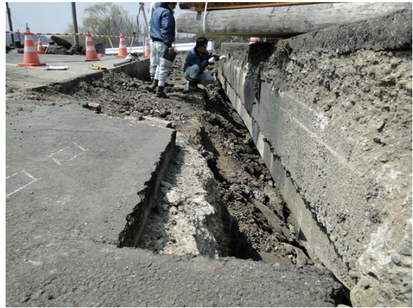
写真-9.87 橋台背面の補修の状況
