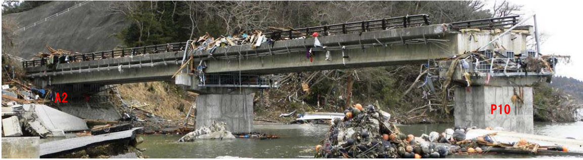
写真-9.122 P 1 0 ～ A 2 間の状況
