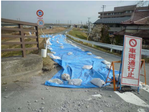
写真-9.152 右岸（江合橋 A 1 下流側）の堤体状況：堤体上の道路は通行止めとなっている。
