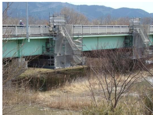
写真-9.54 補修工事足場架設状況
