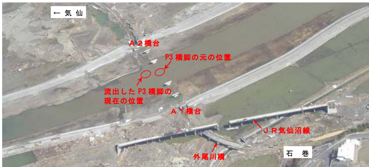
写真-9.110 小泉大橋及び外尾川橋周辺の航空写真 (国土交通省東北地方整備局提供 2011年3月19日(地震発生から8日後)撮影)
