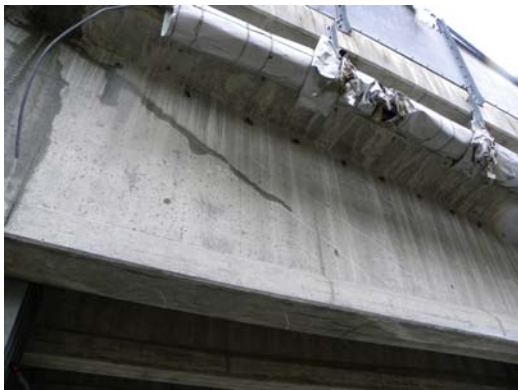
写真-9.131 斜めひび割れの発生状況 (P 1 ~ P 2 間 G 1 側)
