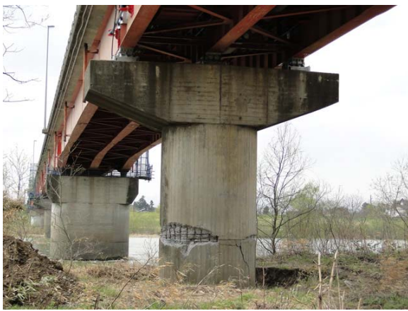
写真-9.107 藤橋の P 6 橋脚の段落し部の損傷
