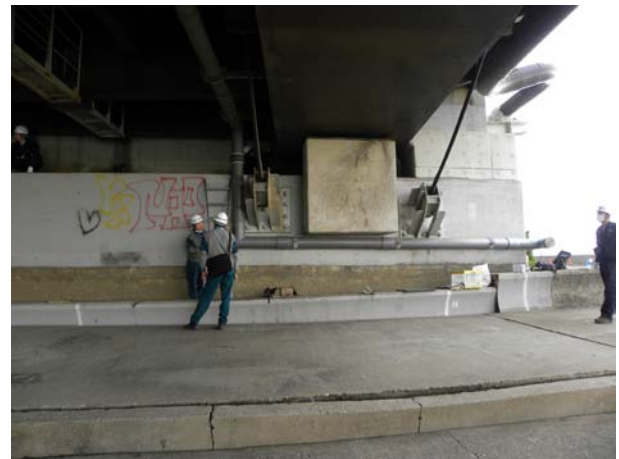
(e) 橋台壁および前面護岸の状況
