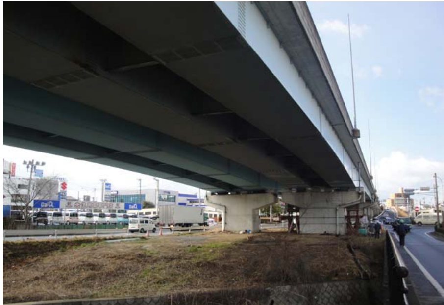
写真-9.36 亀田大橋（福島側より、左：上り線（2期線）、右：下り線（1期線））
