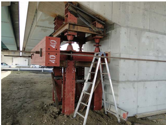
(a) 支保工の設置
