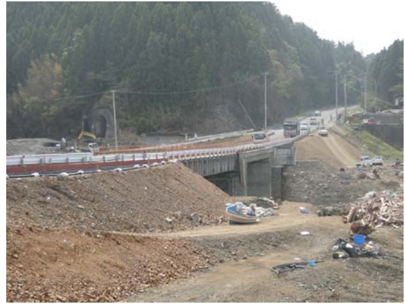
写真-9.139 応急復旧橋設置状況 (6月4日撮影)
