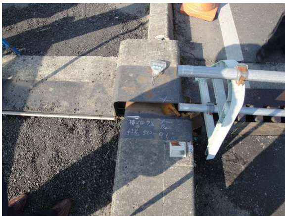
写真-9.21 A 2 橋台上の伸縮装置の状況
