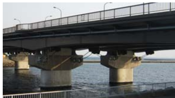
(b) 拡大写真(橋脚)
