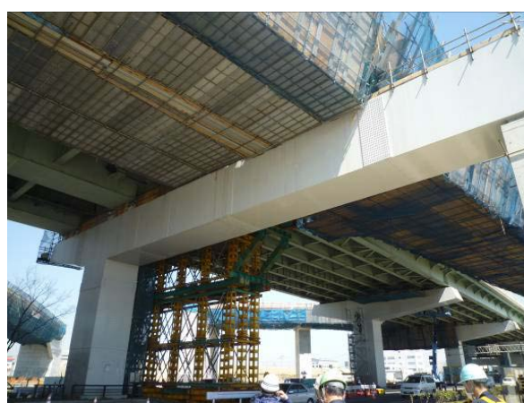
写真-9.65 P 5 6 橋脚及び P 5 8 側の状況
