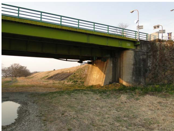
(a) 下流側より撮影
