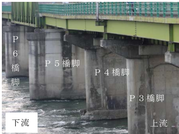
写真-9.90 P 3～P 6 橋脚
