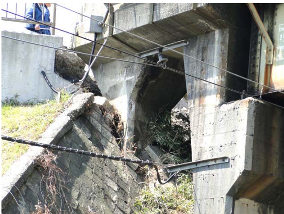
写真-9.88 橋台背面の沈下と橋軸直角方向への横ずれ
