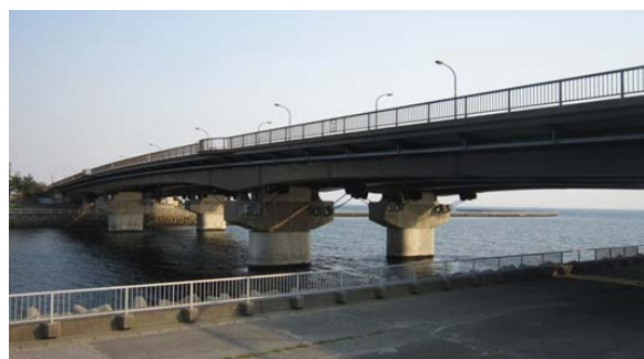
(a) 上流・右岸側 (A 2 橋台側) より
