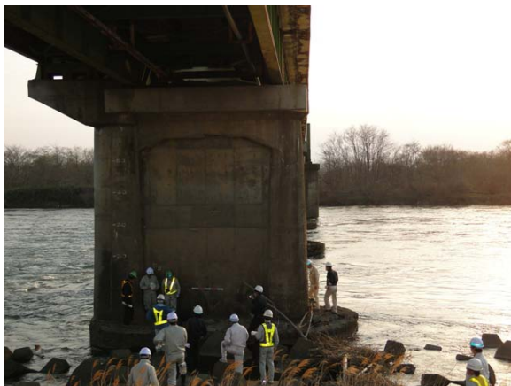
写真-9.96 P 2 橋脚の近接目視調査の状況 (A 1 橋台側から撮影)
