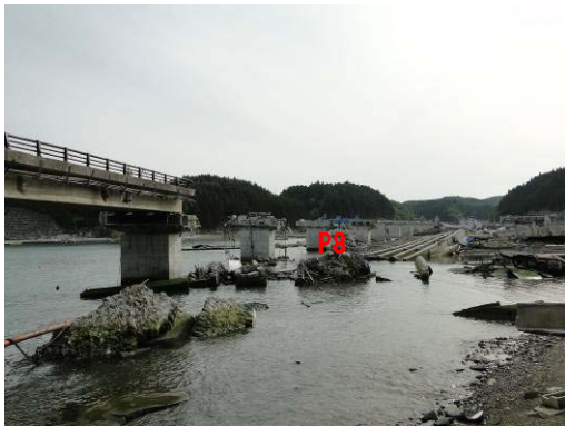
写真-9.125 P 1 0 から見た A 1 側の状況
