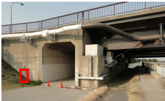
(a) A2 橋台全景(河口側より撮影)
