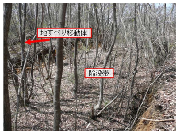
写真-10.46 地すべり頭部の陥没帯
