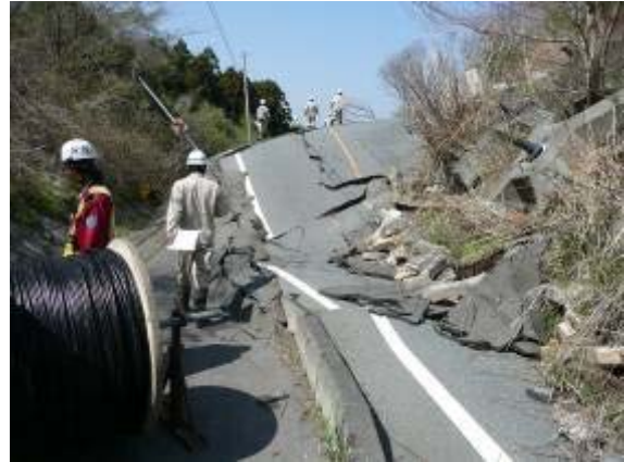
写真-10.42 末端部の路面の隆起
