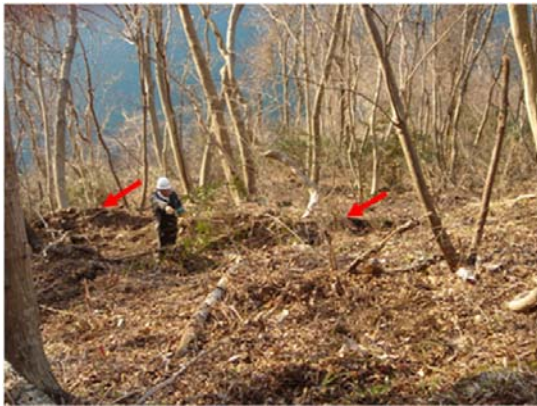
写真-10.36 斜面内に生じた亀裂 (矢印の部分)
