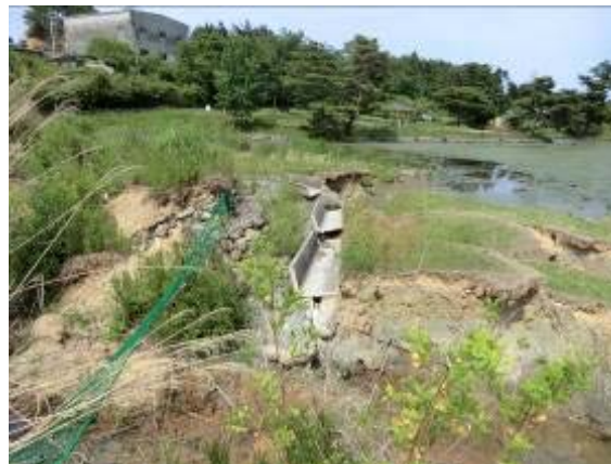
写真-10.11 末端内の状況
