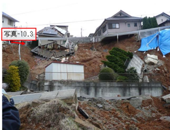
写真-10.2 崩壊上部の状況
