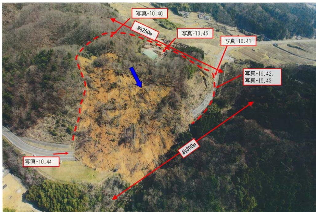
写真-10.40 地すべりによる県道の被災状況 (全景)
