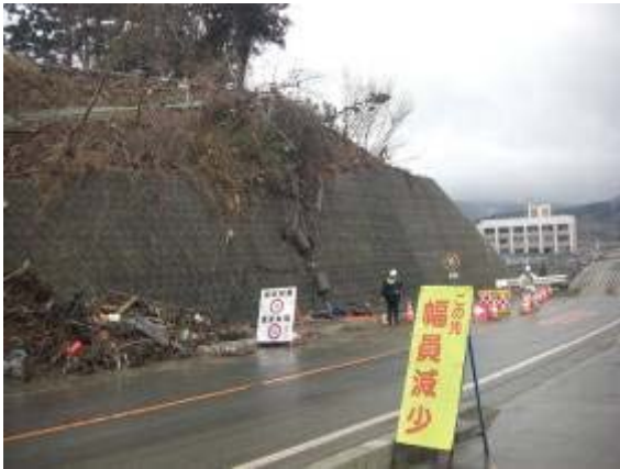
写真-10.58 切土のり面のブロック積擁壁 (南三陸町志津川) (津波が擁壁の上端を越えたが、擁壁には被災がなかった)
