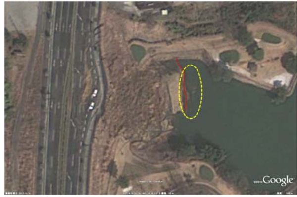
写真-10.17 崩壊後の沼の状況
