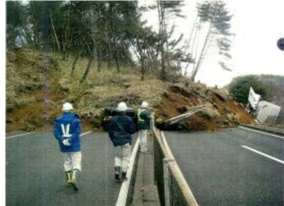
写真-10.5 道路を閉塞した崩土
