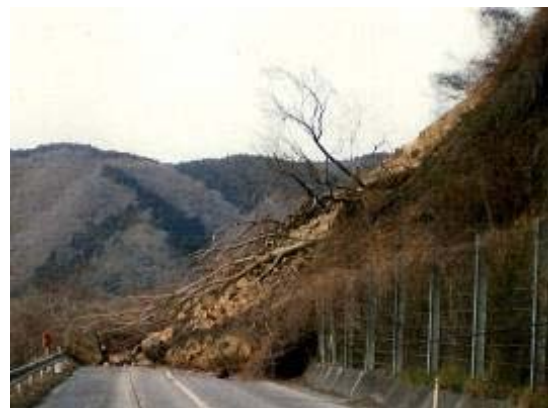
写真-10.34 本震から約3日後の状況
