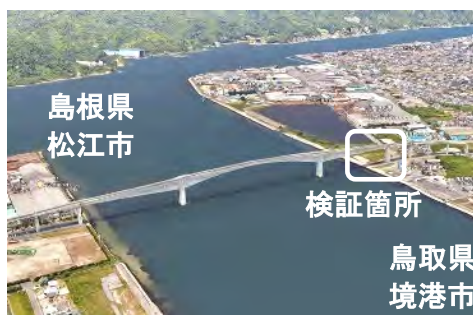
図 2-1 規模が大きいコンクリート橋の例
