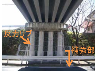
一般国道の橋梁に適用された Kui Taishin-SSP工法
