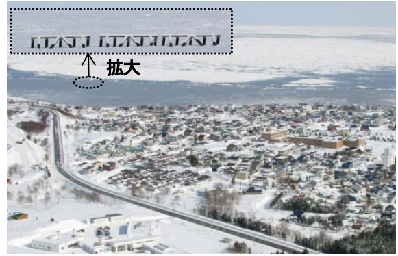
写真-4 防水柵による海水の制御状況
