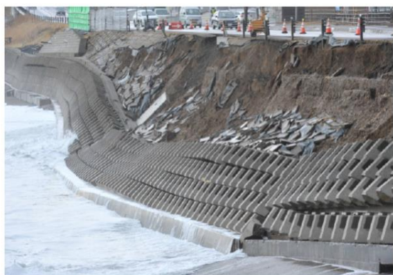
図-9 高波により海岸道路の護岸法面が被災した様子（江差町、2014年12月4日、北海道開発局函館開発建設部報道資料）
