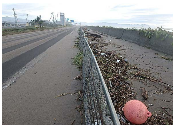
図-14 高波により道路に砂礫等が打ち上がった様子（長万部町、北海道開発局函館開発建設部提供）
