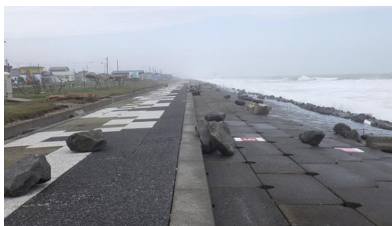
図-2 2016 年 8 月の台風 10 号による胆振海岸被災の様子 (寒地土木研究所撮影)
