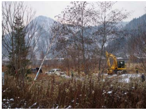
写真-3 樹木引き倒し試験
