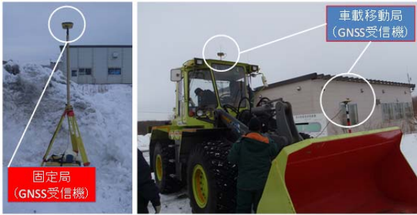
図-8 RTK-GNSS 設置状況
