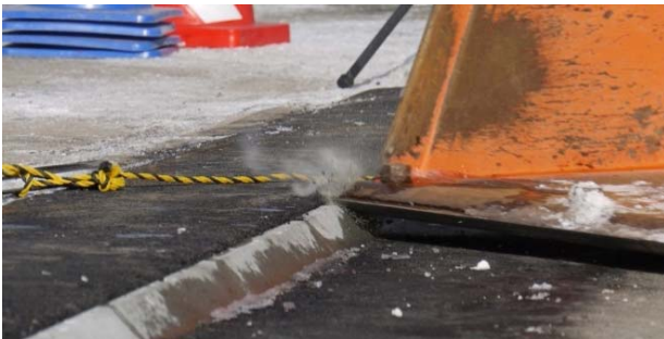
写真-7 バケット接触状況 （傾斜角度 45 度，ホイールローダ）
