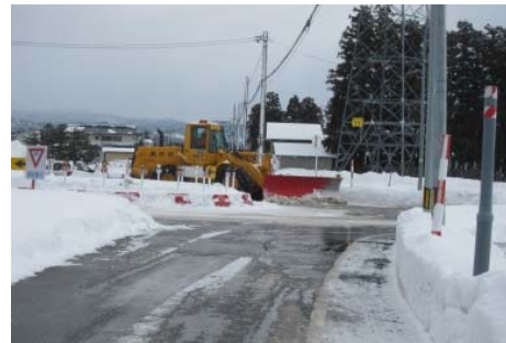
写真-11 ラウンドアバウトにおける除雪作業 (長井市平山)
