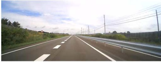
(1) GR (ガードレイル) 区間
