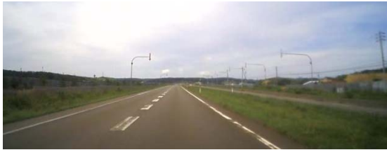
(2) 広幅員区間 写真-2 中央分離構造
