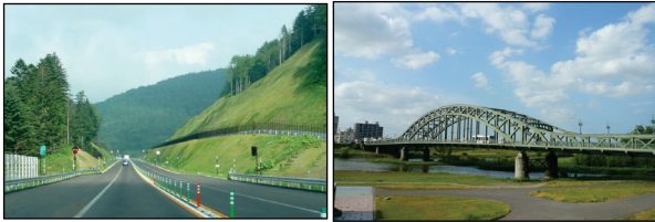
写真-2 道路施設の色彩に求められる機能（左：車線誘導や線形認知、右：耐久・耐候性や地域アイデンティティ）
