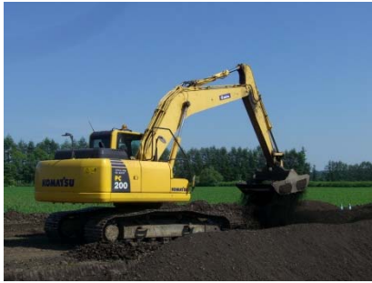
写真-4 ストーンローダー
