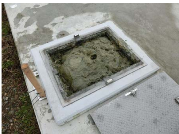
図-9 施設A調整槽内の発泡状況(2016/11/1撮影)
