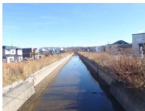
図-4 住宅地を通過するH幹線用水路の外観
