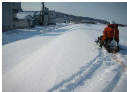
写真-1.1 十勝地方南部地震（2013 年 2 月 2 日 利別川左岸 KP39.2km 付近をスノーモービルで目視点検）（北海道開発局提供）
