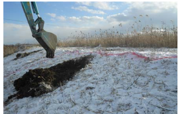
写真-3.3 バックホウによる掘削の状況
