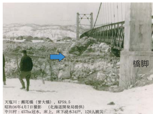
写真-1.2 天塩川アイスジャム（1961 年 4 月 7 日 瀬尾橋（菅大橋）天塩川 KP59.5 付近）（北海道開発局提供）
