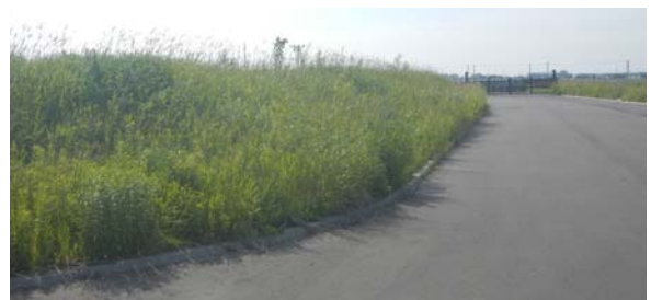
写真-3.1 豊平川河川防災ステーション備蓄盛土
