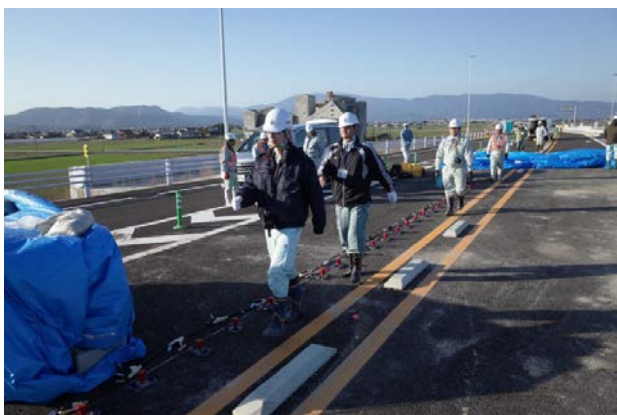
図-8 現場担当者との共同による計測調査風景
