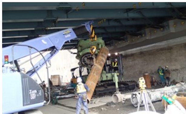
写真-3.1 既設橋台基礎の補強事例
