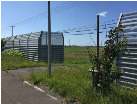
図-7 開口部対策として調査区間に設けられている副防雪柵
