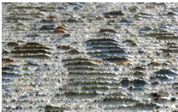
写真-4 DG 施工後の表面の仕上がり
