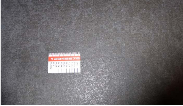
写真-6 施工前の路面状況
