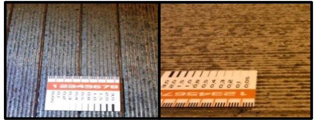
写真-11 DG工法施工後の表面の仕上り
