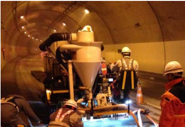
写真-7 DG施工機械
