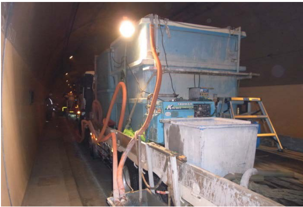
写真-8 トラック(濁水タンク(手前), 水タンク(奥))
