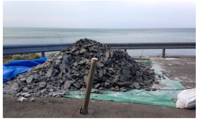
写真-10 濁水の脱水ケーキ(水はDG施工に再利用)
