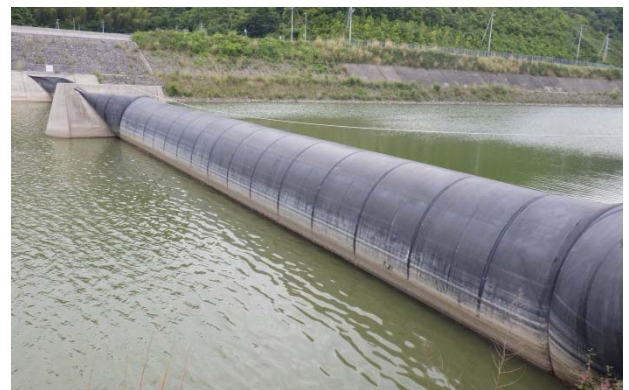
写真-1.1 ゴム堰全景写真
