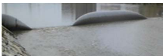
写真-5.1 Vノッチ発生状況
