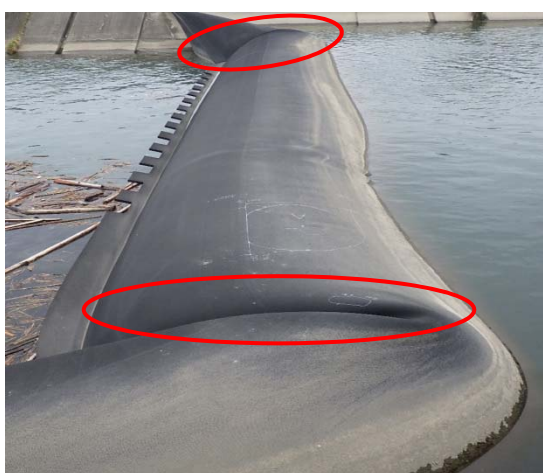
写真-5.4 堰両端屈曲部
