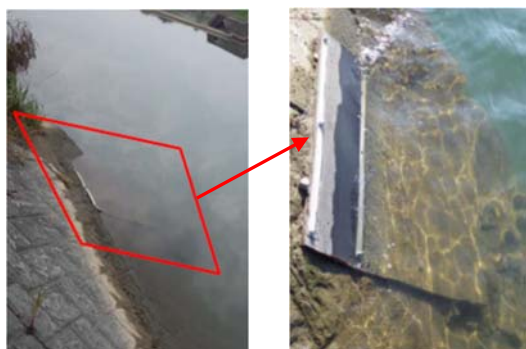
写真-4.7 浸水暴露事例
