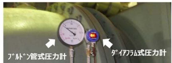
写真-4 吐出管へのダイアフラム式圧力計の設置状況
