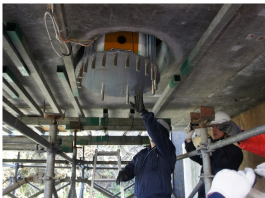
図-3 マンホールからの機器の搬入
