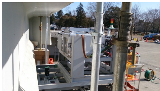
図-4 撤去桁の撮影状況
