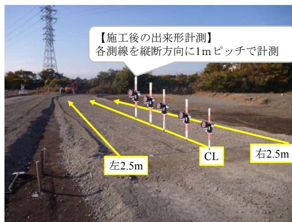
写真-4.2 出来形計測容量
