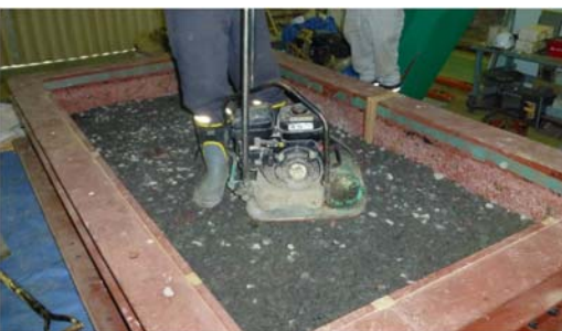
写真-2.3 路盤の締固め状況 (プレート)
