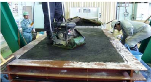
写真-2.4 表層の締固め状況 (プレート)
