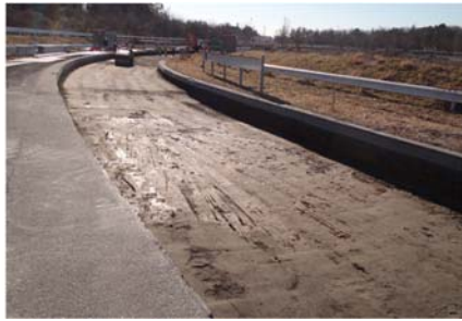
写真-2.8 試験施工箇所（路床施工時）
