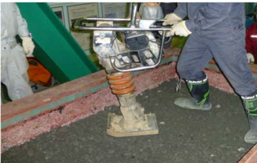
写真-2.2 路盤の締固め状況 (タンパー)
