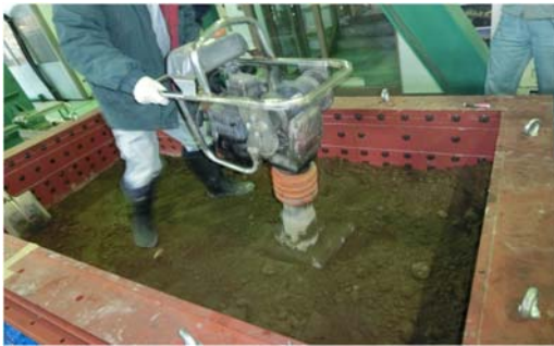
写真-2.1 路床の締固め状況 (タンパー)
