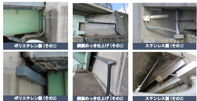
図-22 簡易排水樋の設置(止水機能多重化)
