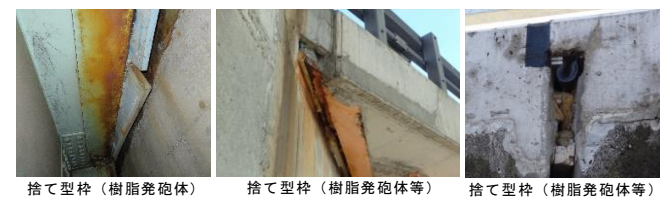
図-27 後打ちコンクリート打設時の捨て型枠
