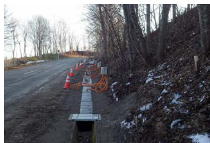
試験施工箇所②
