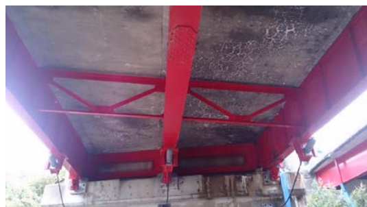
写真-1 対象橋梁の床版下面の状況
