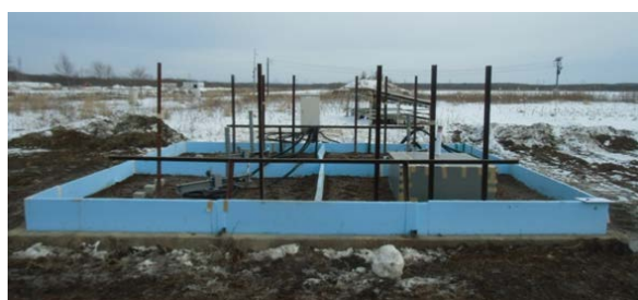
写真-2 施工状況
