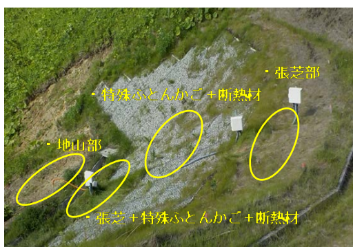
写真-4 試験施工箇所の状況
