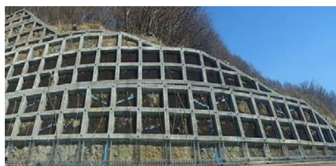
写真-1 現地状況
