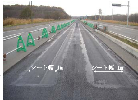
写真-2 ひび割れ抑制シート貼り付け後の状況
