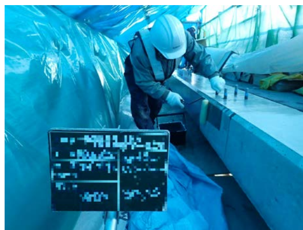
写真-1 厳冬期における防寒仮囲い内でのシラン塗布状況の一例（手前の黒板は画像処理を行っている）
