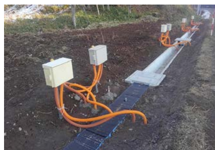
試験施工箇所①
