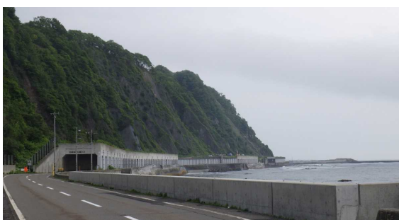
図-14 岩礁地帯に建設された海岸道路（国道 336 号、モイケン第一覆道付近、寒地土木研究所撮影）
