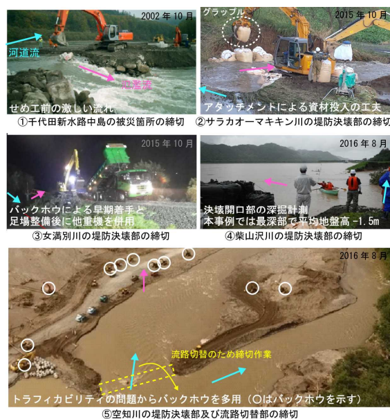
図-1 北海道における堤防決壊時の緊急対応工事一例
