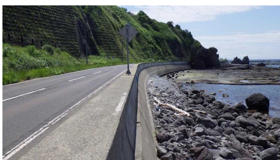
図-13 岩礁地帯に建設された海岸道路（国道 229 号、八雲町熊石、寒地土木研究所撮影）
