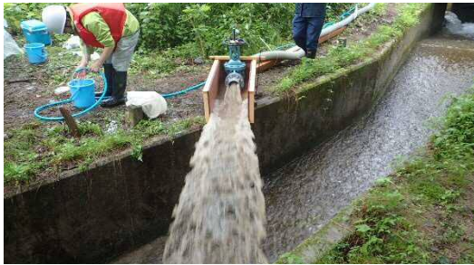
図-23 吐口部の排砂時の状況
