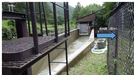
図-15 水槽兼沈砂池（排砂時）
