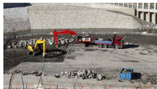
図-3 小渋ダム土砂バイパストンネル呑口部における掘削の様子
