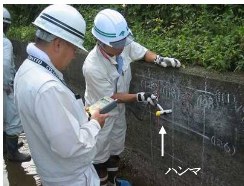
図-17 機械インピーダンス法による測定状況 33)
