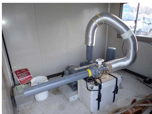
図-2 曝気ポンプの流量測定
