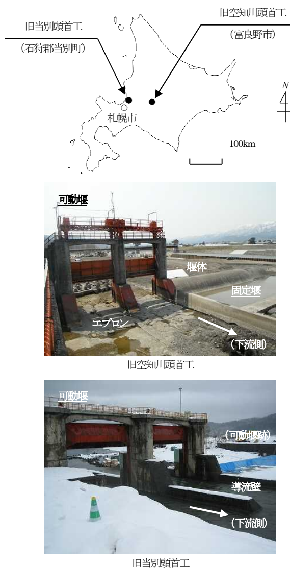
図-1 各頭首工の位置および撤去時の状況
