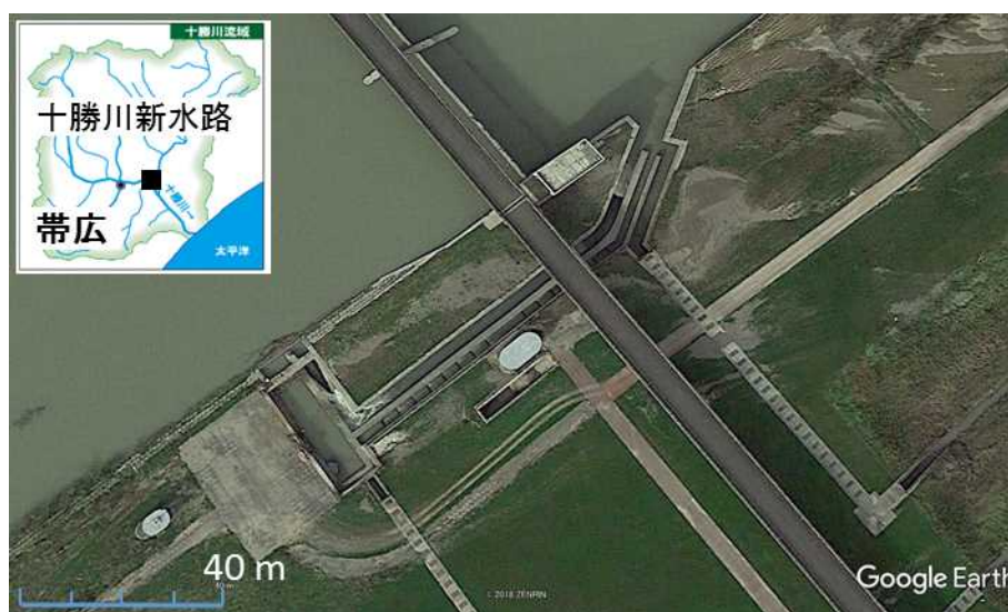
図-2 十勝川新水路とサケカウンター設置箇所
