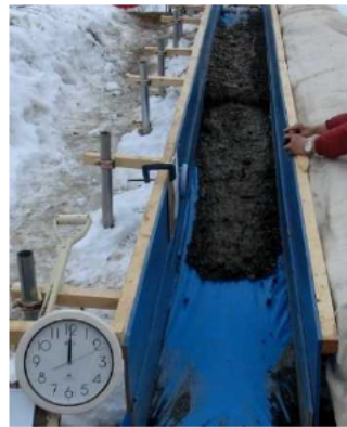
写真-12 泥流流下状況(陰が映らない敷設厚7.5cmの例)
