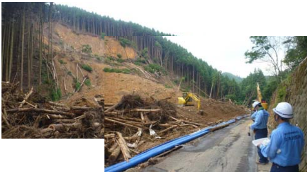
写真-4 厚い風化層の深層崩壊の事例
