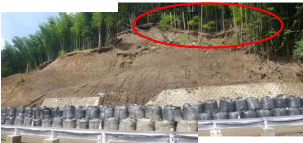
写真-3 集水地形直下の表層崩壊の事例 崩壊斜面の上方に集水地形(赤丸内)が存在する。
