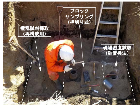
図-2.2 箇所No.2のブロックサンプリング状況 (同様の作業を隣接した3箇所で行った)
