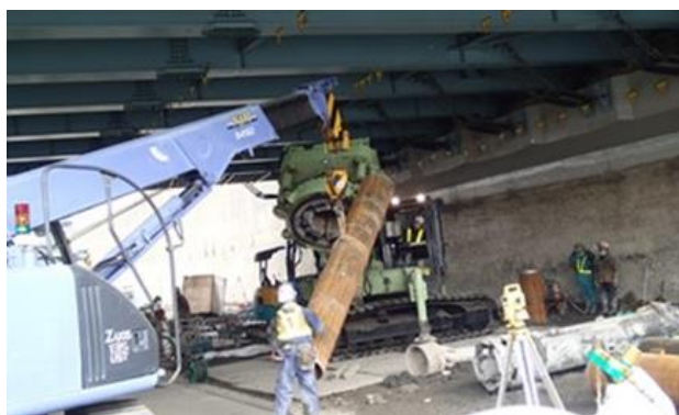
写真-3.1 既設橋台基礎の補強事例
