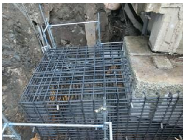
写真-3.2 橋脚～基礎一体型の下部構造の補強事例
