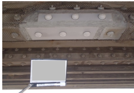
写真-4.8 代替防食版設置完了
