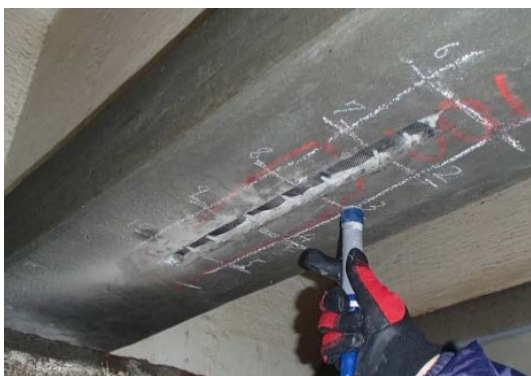
写真-4.3 表面電位測定状況
