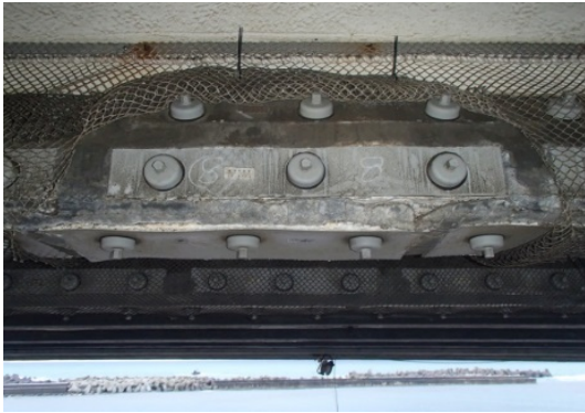
写真-4.5 既設防食版(亜鉛シート)
