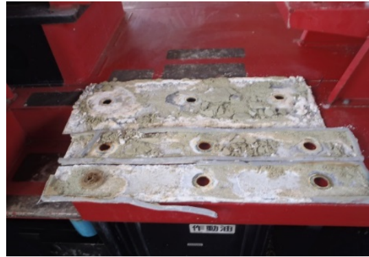
写真-4.6 亜鉛防食版撤去完了
