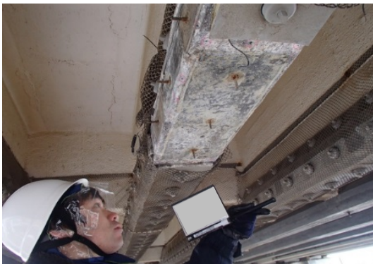
写真-4.7 コンクリート表面確認
