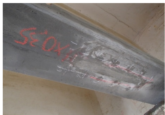
写真-4.4 モルタル被覆完了
