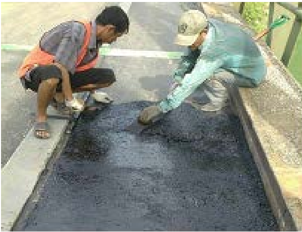
(a) アスプトングースアスファルトの舗設
