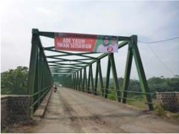
図-3 Cisadane 橋の外観
