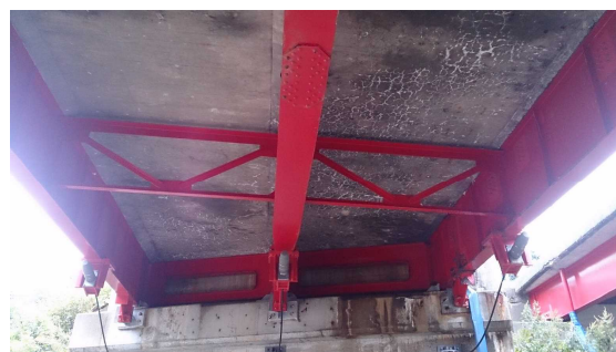
写真-2.1 対象橋梁の床版下面の状況
