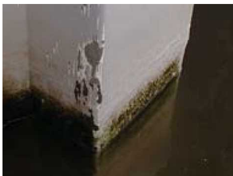
写真-2.3 補修後の矢板凸部側面への衝突痕
