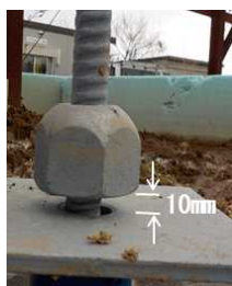
写真-3.6 ナットの状況 (CASE D)
