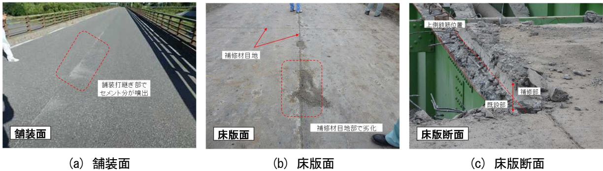
写真-3.1 A橋の状況
