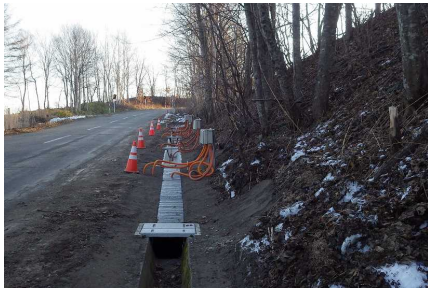
試験施工箇所②
