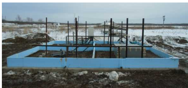
写真-3.1 施工状況
