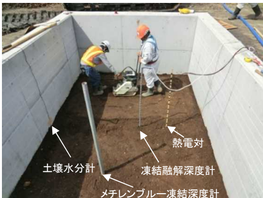
写真-2.1 計測機器埋設状況
