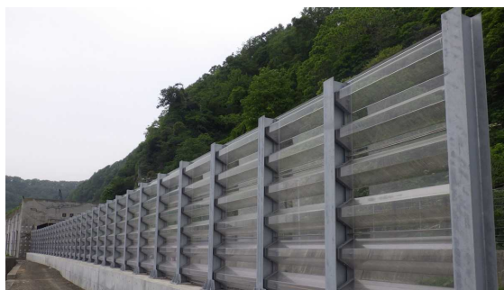
図-15 透明ポリカーボネート製の越波防止柵（国道 336 号、広尾町美幌覆道付近、寒地土木研究所撮影）
