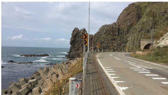
図-12 岩礁地帯に建設された海岸道路（国道 231 号、増毛郡、岩尾トンネル付近、寒地土木研究所撮影）
