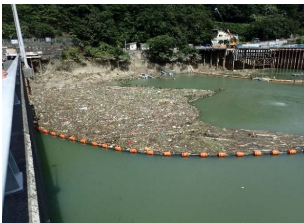
図-5 ダム堤体まで到達した塵芥等の状況
