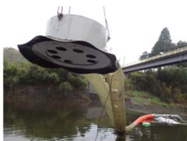
図-33 管径 300mm 潜行吸引式排砂管
