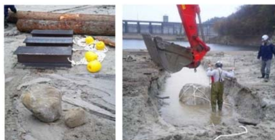
図-11 試料の埋設状況写真(水位低下時)
