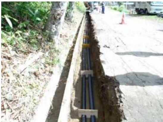
写真-3.8 浅層埋設の施工状況（千歳市提供）
