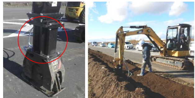
写真-4.5 コンパクタ A (スペーサー取付)
