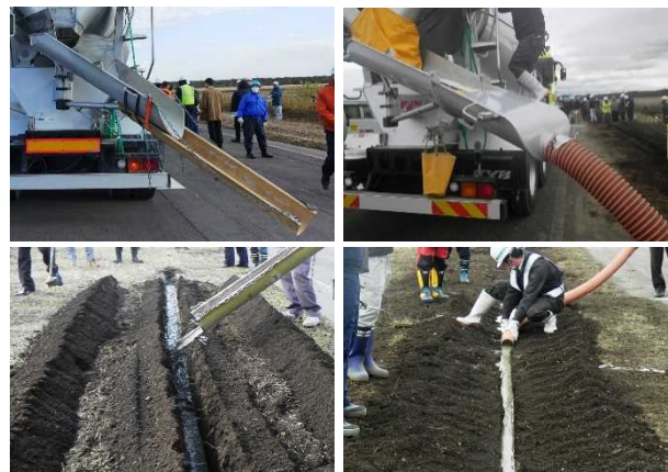
写真-4.4 流動化処理土の施工状況 (左:樋を使用 (H29)、右:ホースを使用 (H30))
