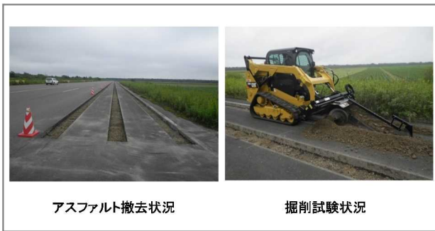
写真-4.2 アスファルト撤去および掘削試験状況
