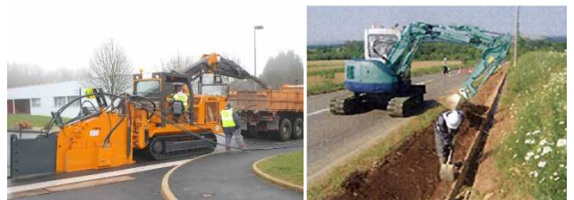
写真-4.1 左：海外における専用機械による施工例 (ウェブページより引用 10) ) 右：国内における油圧ショベルによる施工例 (北海道内自治体提供)
