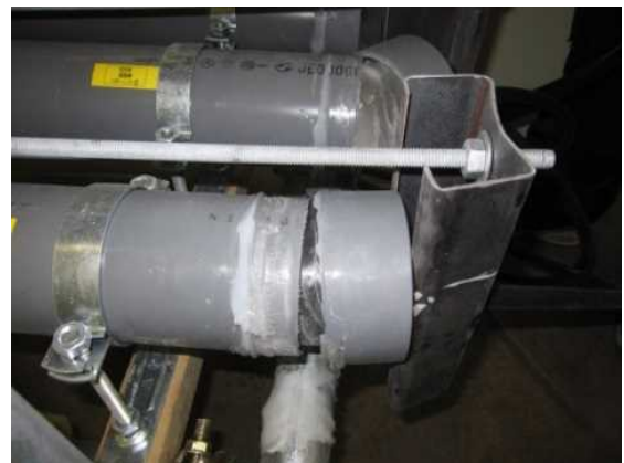
写真-3.5 満水凍結後の供試体蓋部
