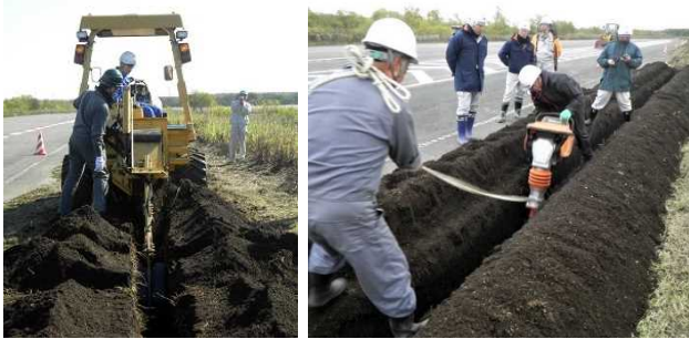
写真-4.6 掘削土の堆積状況
