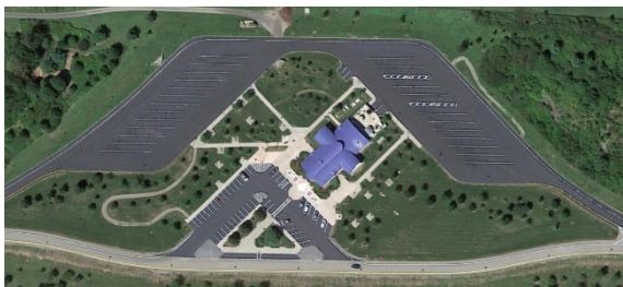
写真-12 Allegany River Rest Area (画像データ: Google) (一般車とトラックの駐車場が分離され、広いピクニックエリアを有する)
