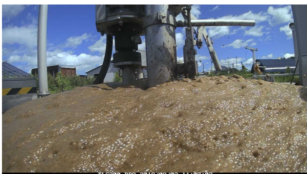
図-19 施設Iでの泡溢流停止直後の状況 (2018/9/2 11:07)
