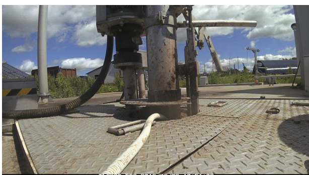
図-18 施設Iでの泡溢流開始直前の状況 (2018/9/2 10:51)
