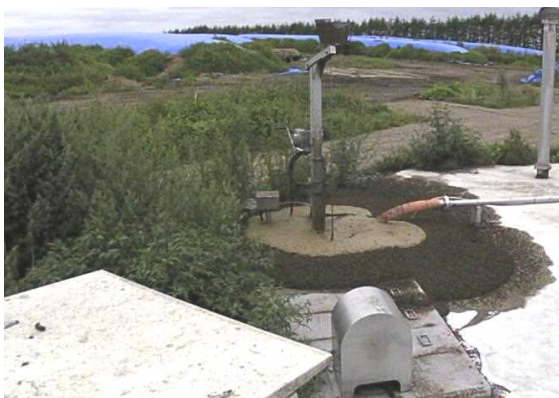
図-16 施設Bでの泡溢流停止直後の状況 (2018/9/4 12:59)
