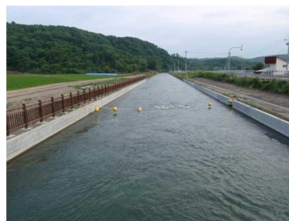
図-2 灌漑期におけるH幹線用水路の外観
