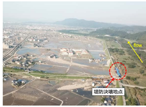
図-2 小田川決壊地点周辺の被災状況
