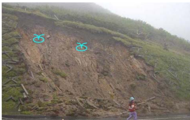
(a) 被災状況
