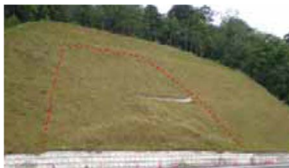
写真2-14 表層の風化による事例（地山：砂岩泥岩）
