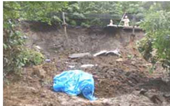
写真 2-7 のり肩流入で規模が大きかった事例
