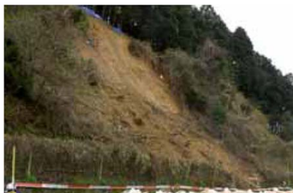
写真2-13 表層の風化による事例（地山：花崗岩）
