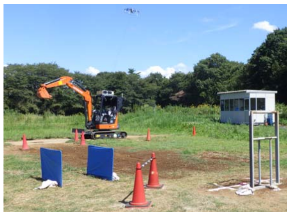
図-7 有線給電UAV実験状況
