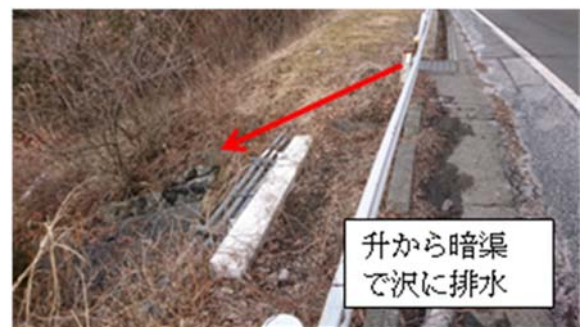
写真2-2 表面流の排水系統
