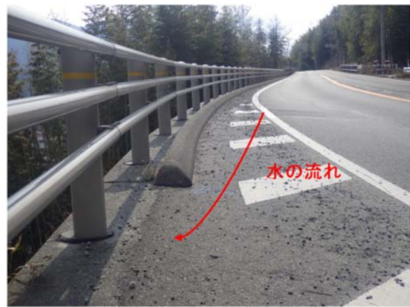
写真 2-6 アスカーブ箇所(端部流入)
