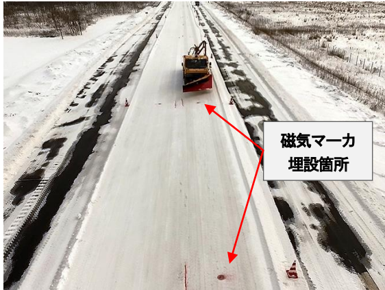
写真-14 自車位置測位実験 (直線部)
