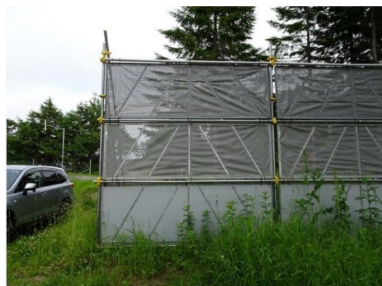
図41 茶内防雪林で施工されているネット柵工
