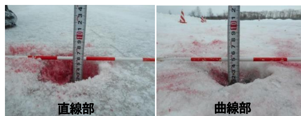
写真-13 走行車線積雪状況
