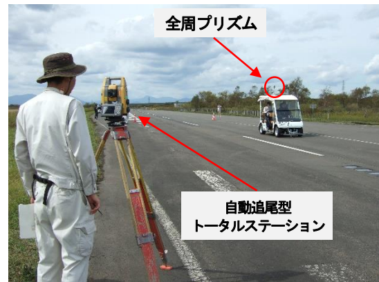
写真-10 TSによる計測状況 (直線部)
