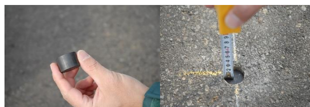
写真-12 磁気マーカ埋設状況
