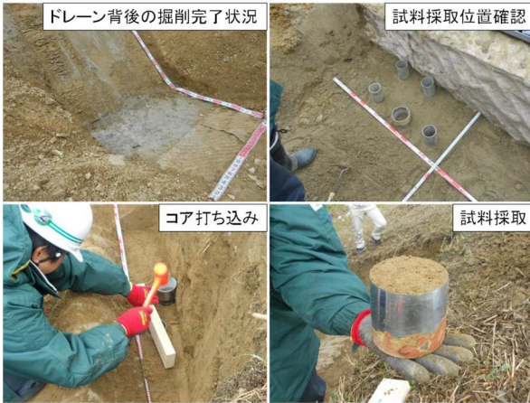
写真-1 土質試料採取状況
