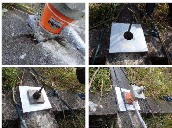
写真-4.2 法枠の補修状況
