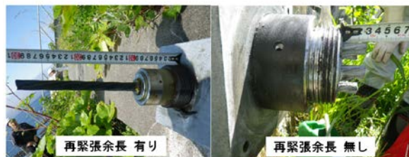
写真-3.1 アンカーの再緊張余長の例
