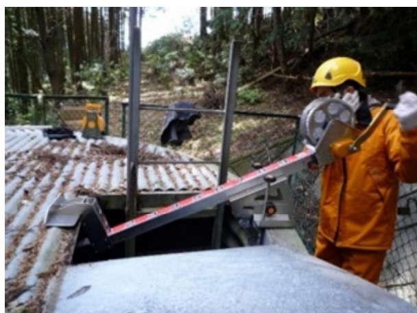
図-6 昇降機の固定状況
