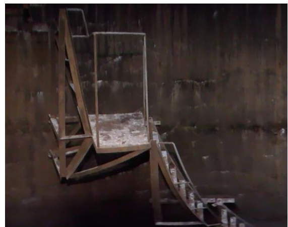
図-12 タラップの状況
