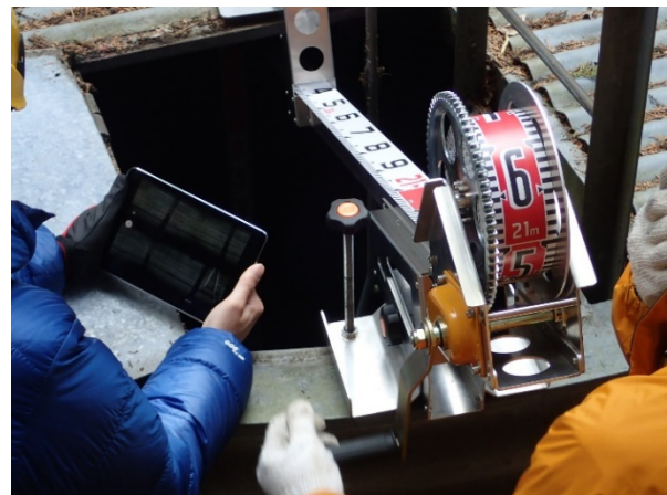
図-3 撮影部による集水井内部のリアルタイム確認状況
