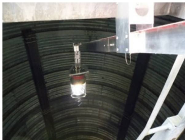
図-7 撮影部の吊り下ろし状況
