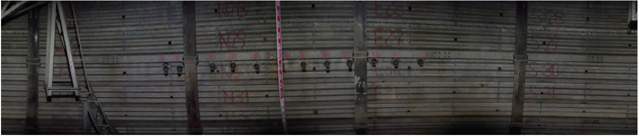
図-13 ライナープレート製集水井の 360 度展開写真
