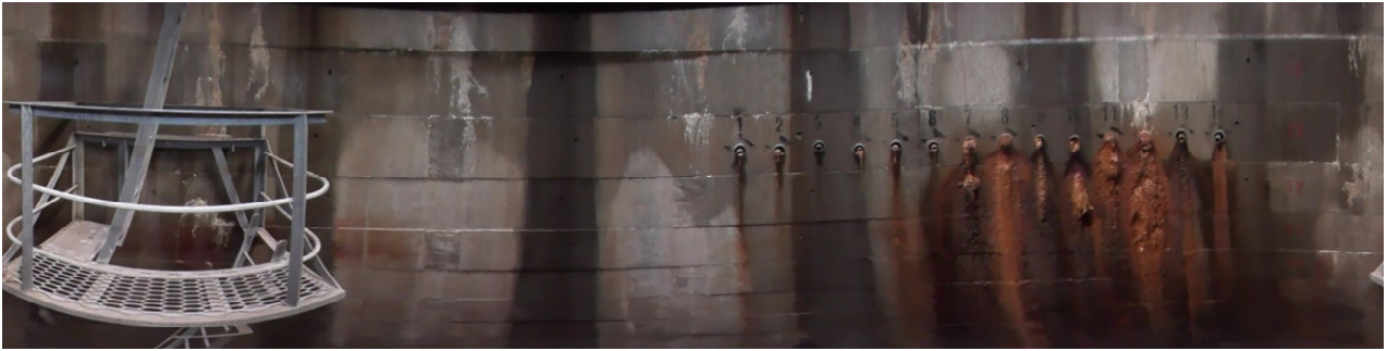
図-8 コンクリート製集水井の360度展開写真
