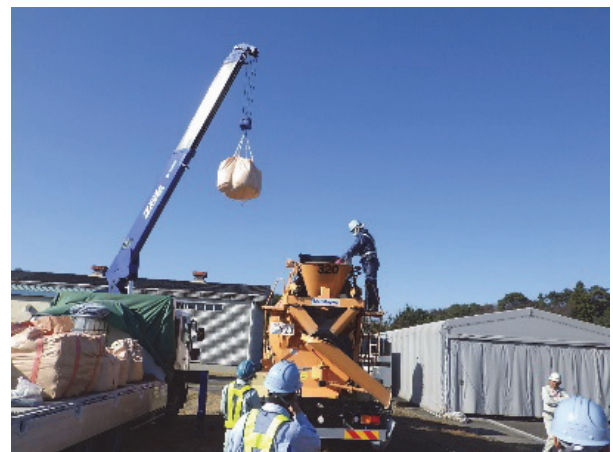
写真-4.1 速硬性混和材投入状況 (FC)
