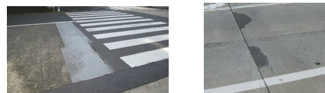
(a) 段差擦付け (b) 角欠け補修
