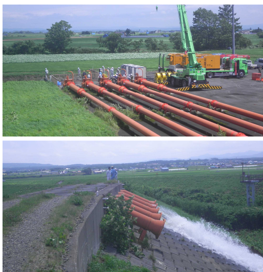
写真-1 救急排水機場外観
