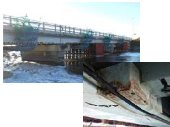
写真-1 橋梁全景（左上）および外ケーブル設置状況（右下）
