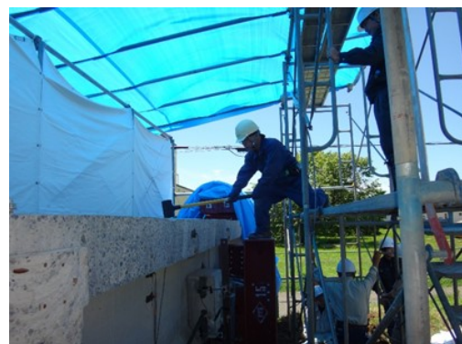
写真 2-4 ハンマーによる加振の様子
