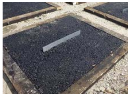
写真3-1 模擬ひび割れ作成
