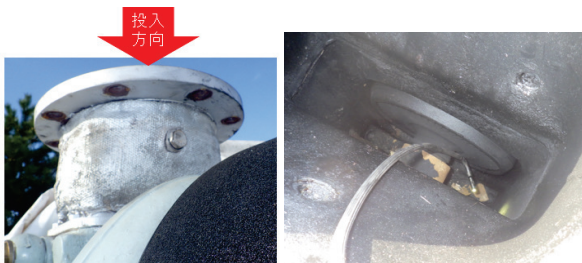
写真-2 内視鏡投入箇所と投入状況
