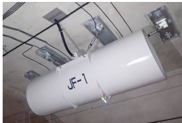
写真-1 JFの設置状況の例
