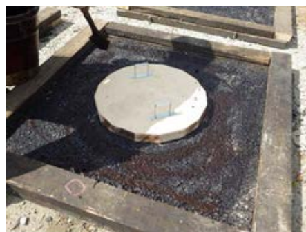
写真3-2 模擬剥離部の円形木枠の設置
