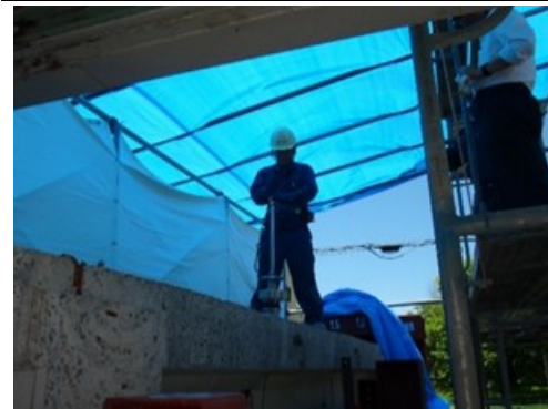
写真 2-3 重錘落下による加振の様子
