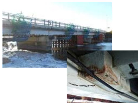
写真 2-1 橋梁全景（左上）および外ケーブル設置状況（右下）
