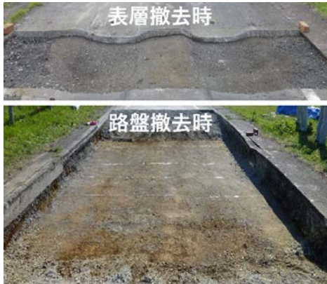
写真 2-2 開削調査時の舗装状況
