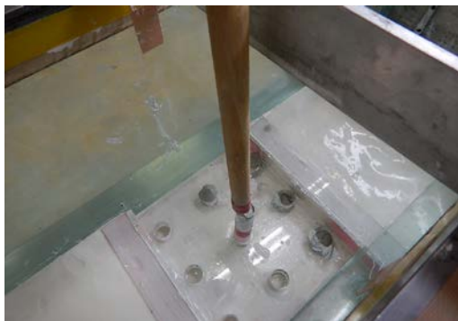
図-4.7 深層改良体の打設
